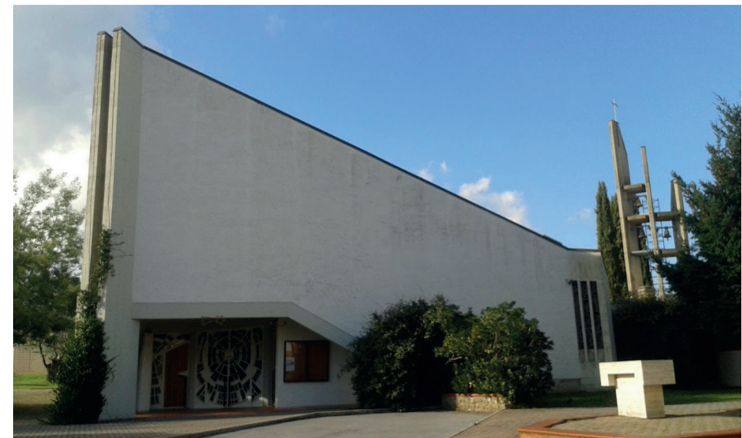
F02 - Chiesa nuova di San Donato di Castelnuovo dei Sabbioni
