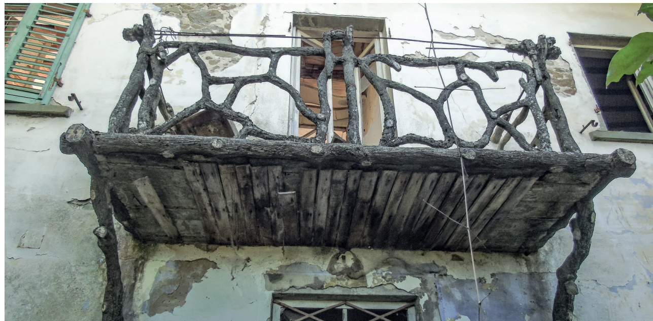
F11 - Balcone in legno, isolato A, edificio A.01
