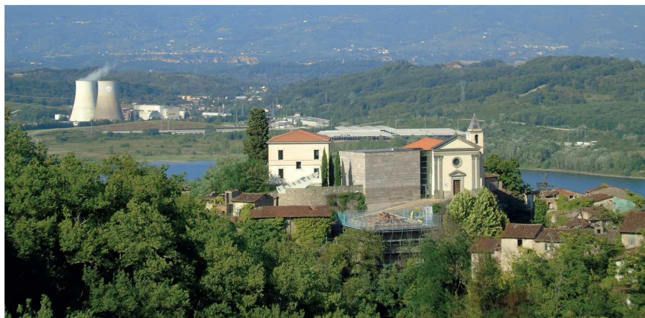
F09 - Stato attuale, 30 luglio 2019, sopralluogo
