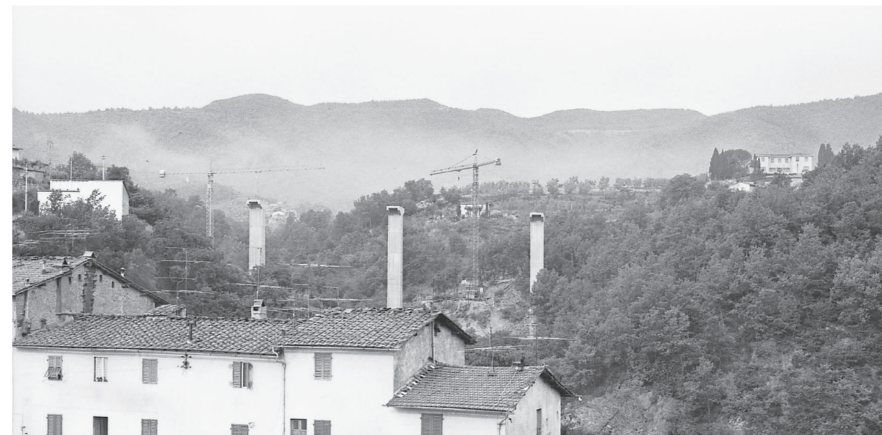
F02 - Costruzione del viadotto di accesso a Castelnuovo dei Sabbioni
