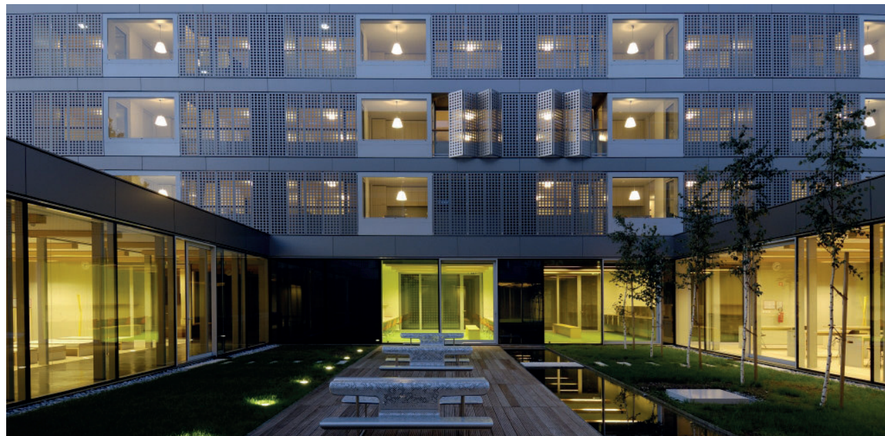
F46 - Vista esterna
