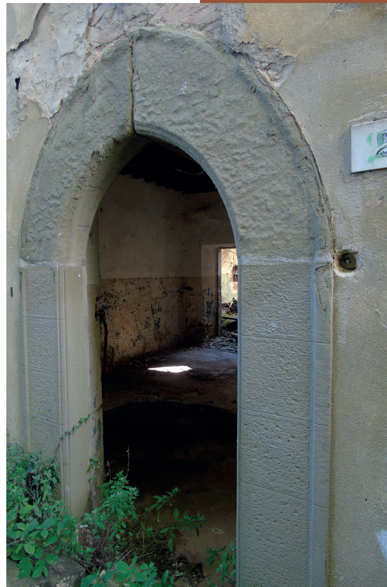
F04 - Ingresso edificio E02
