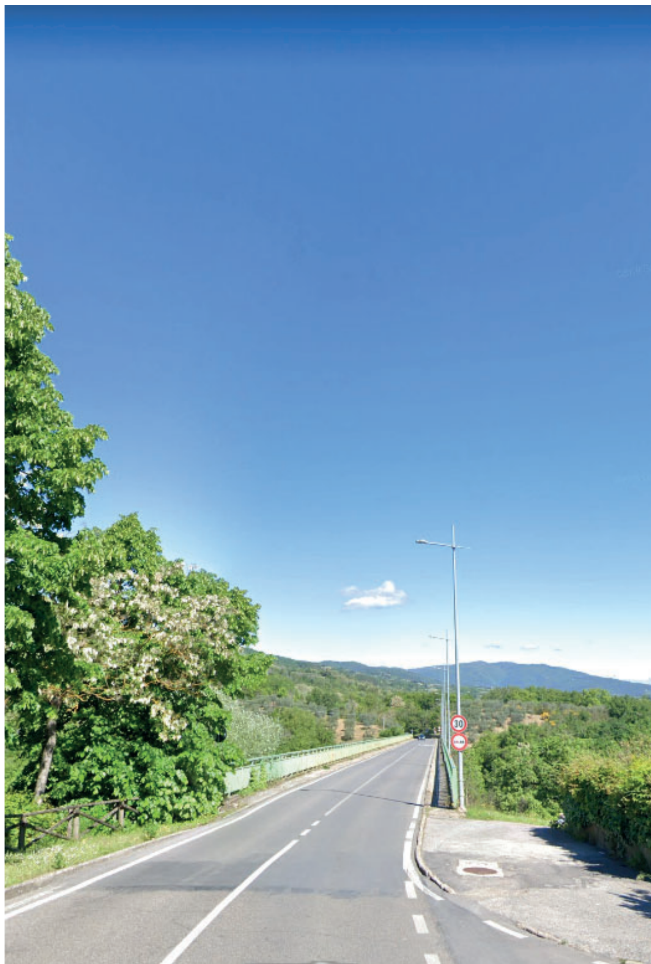
F05 - Viadotto Castelnuovo dei Sabbioni - Santa Barbara
