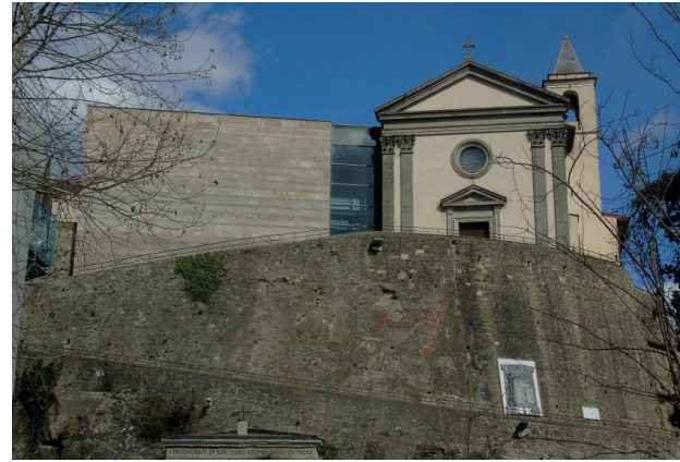
F10 - Chiesa dopo i lavori di recupero
