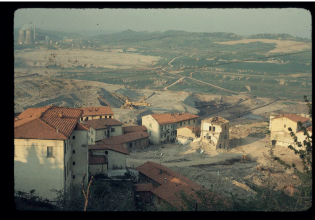
F08 - “Castelnuovo dei Sabbioni Via Mazzini e le Muccherie già demolite. Casa Parisi distrutta”, 20 aprile 1975, Archivio Emilio Polverini
