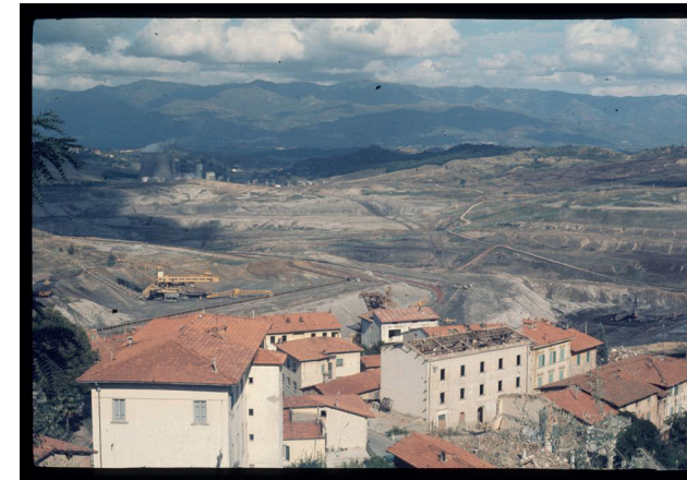
F07 - “Castelnuovo dei Sabbioni Demolizioni delle case di via Matteotti e di via Nuova”, 01 novembre 1974, Archivio Emilio Polverini
