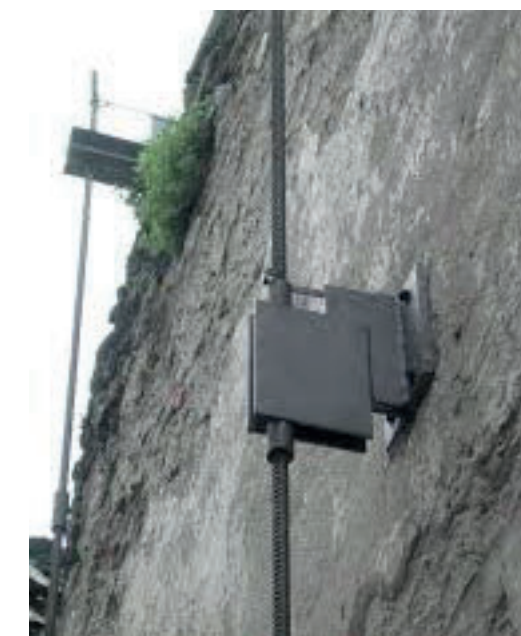
F18 - EHT al Forte Fuentes di Colico
