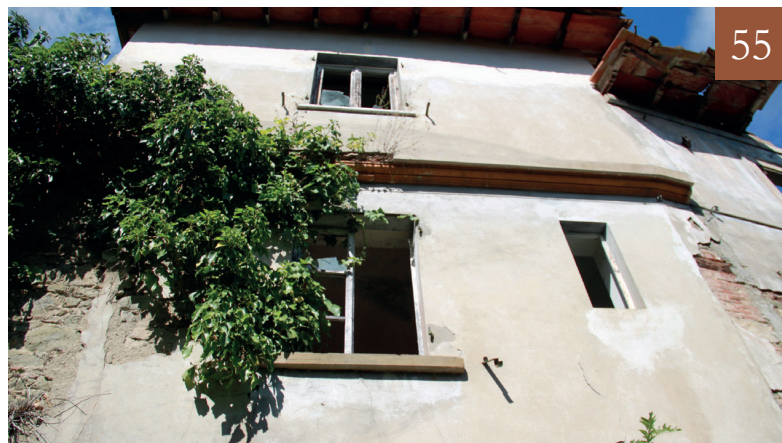
Codice ripresa: 55 Soggetto: Prospetto Est Vista: Prospettica Data: 27/09/2019 Fotocamera: CANON EOS 500D Risoluzione: 350 dpi
