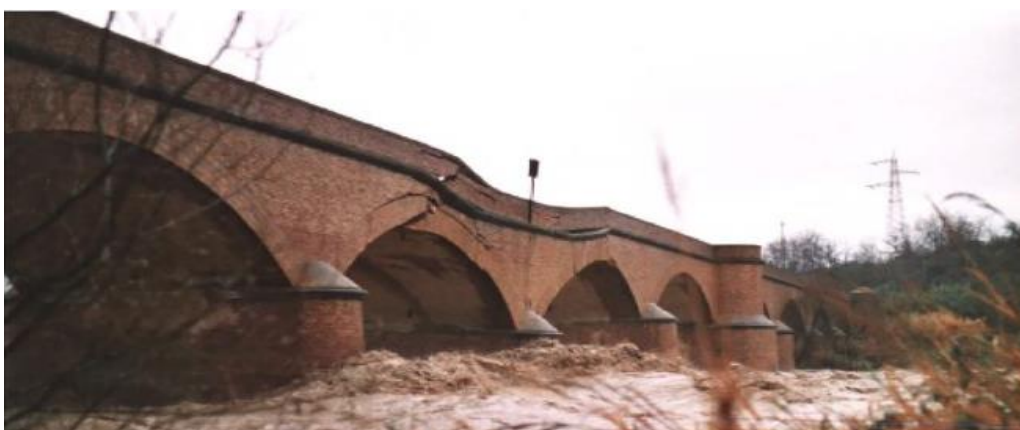
Figura 1.14. Dissesto strutturale del ponte Trigno durante un evento di inondazione nel basso Molise, Italia (Zampieri et al., 2017)
