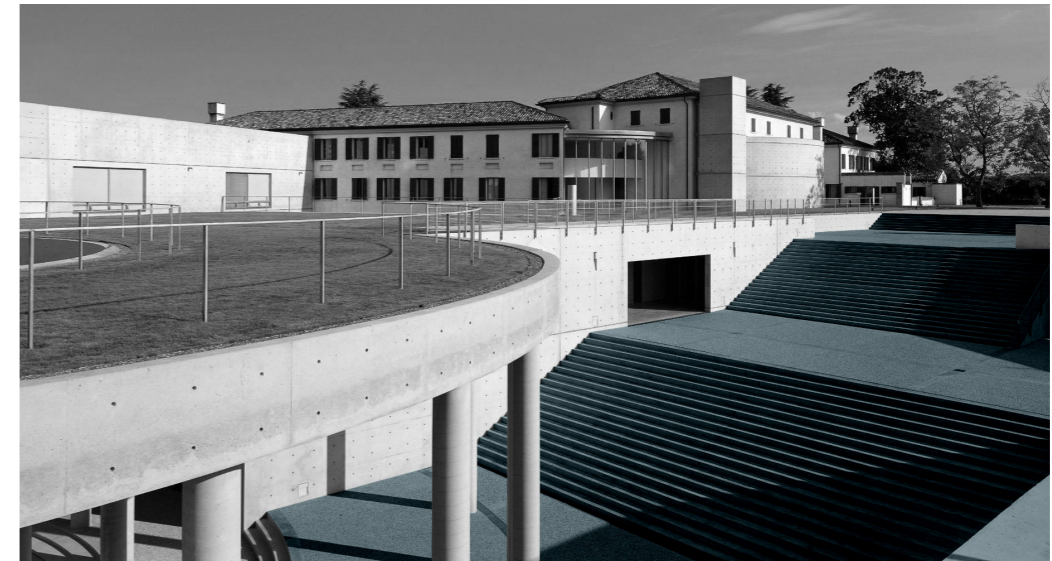
Fig. 46 _ Fabrica Benetton, Treviso, Italia, Tadao Ando, 1994-2000 - Vista della rampa di ingresso
