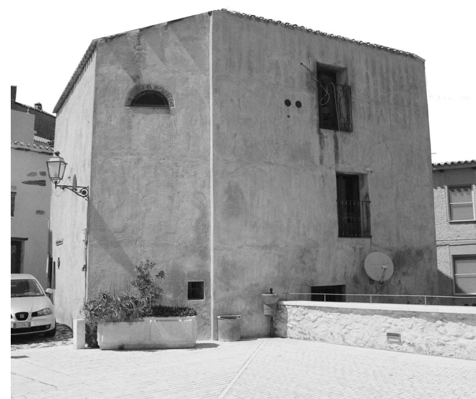
Il tetto a falde in cannucciato, secondo piano
