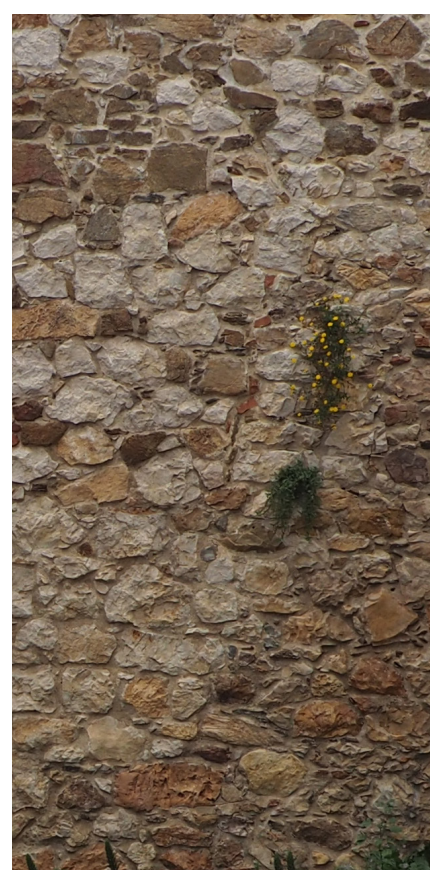
Muratura pietra e malta
