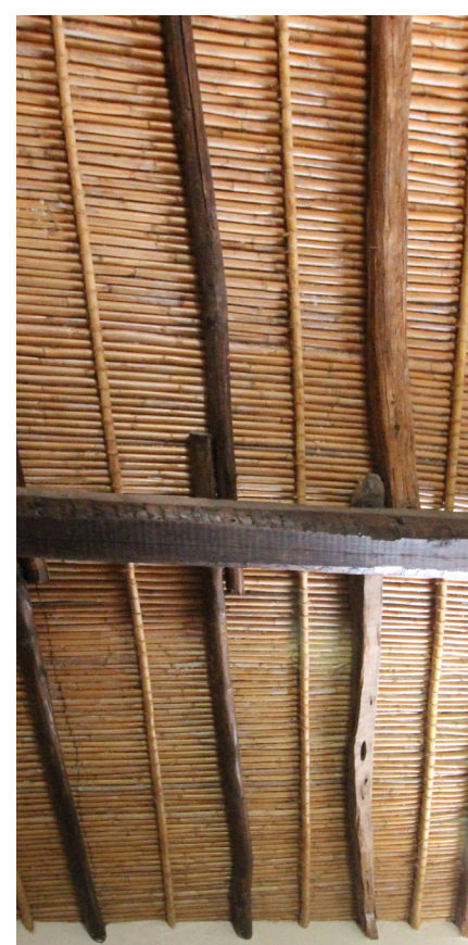
Dettaglio del soffitto voltato
