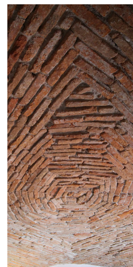
Dettaglio del soffitto voltato
