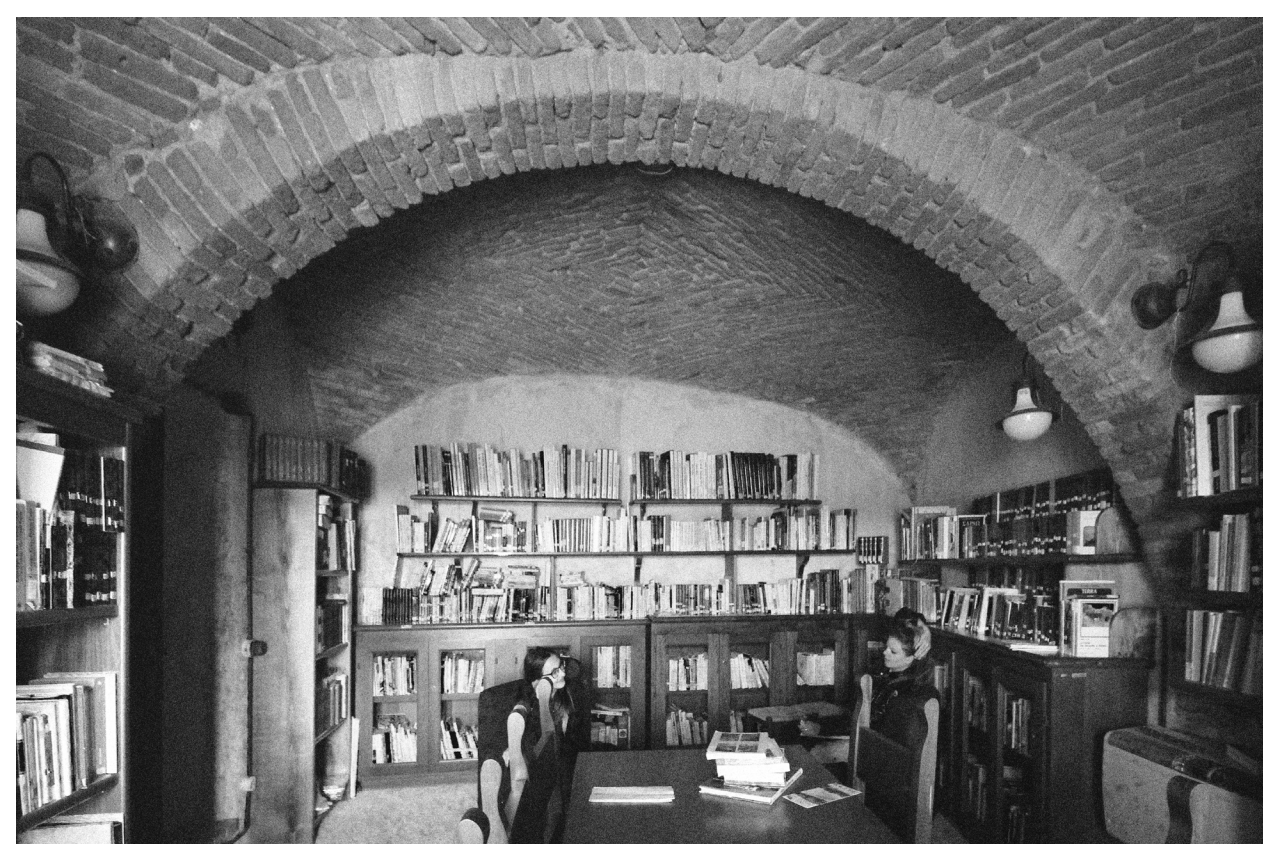
Il soffitto voltato in laterizio della Sala Sardegna, piano seminterrato
