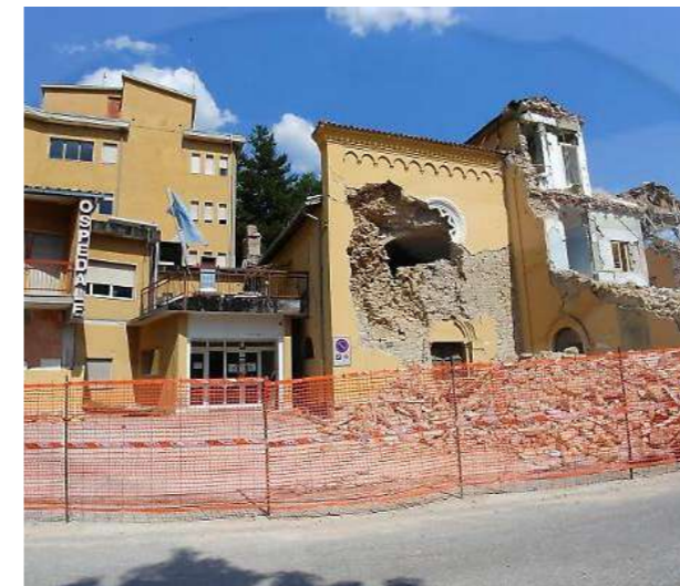
Foto 47 di Emma Moriconi: 28 febbraio 2017, messa in sicurezza dell'ospedale.
