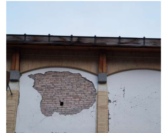
Foto 63 di Martina De Pasquale: 17 novembre 2019, dettaglio costruttivo muratura.
