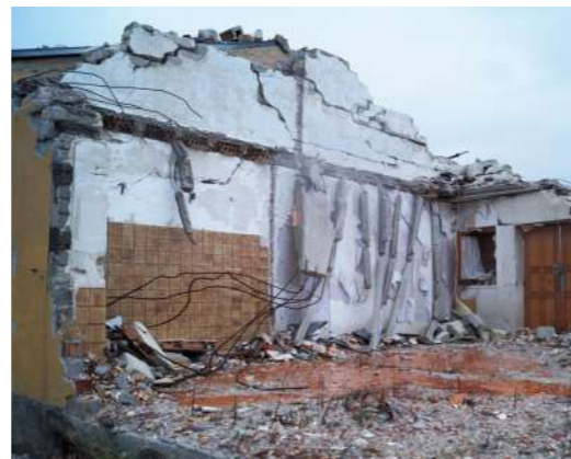
Foto 145 (a sinistra) di Elena Zocchi: 06 maggio 2019, ingresso principale ex Casa di riposo "Don Minozzi", dove si osserva la rottura a taglio delle murature portanti. Foto 146 (in alto) di Veronica Reale: 17 novembre 2019, abitazione distrutta nel centro storico.
