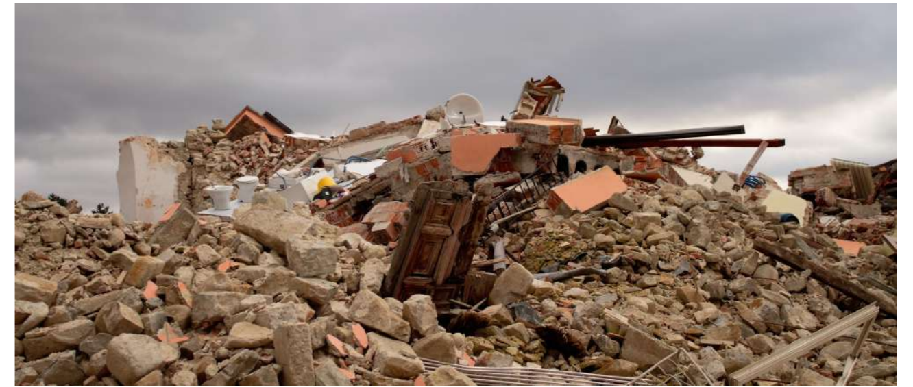
Foto 4 di Emma Moriconi: 4 gennaio 2017, macerie edilizia residenziale.
