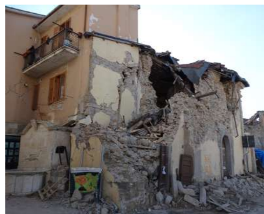
Foto 116 (in alto) di Emma Moriconi: 26 marzo 2017, edificio nel centro storico . Foto 117 (a sinistra): 30 agosto 2016, Amatrice, edificio in muratura che mostra il distacco del paramento più esterno in conci squadri. (fonte: quest).
