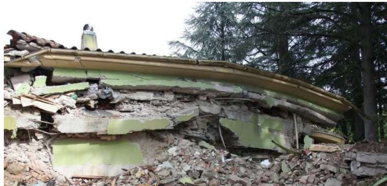
Foto 120: 24 agosto 2016, edificio crollato per il peso di coperture e solai in c.a.e gravanti su murature fragili e vulnerabili, non progettate per sostenerli (fonte: Quest).
