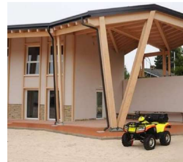
Foto 173 (a sinistra) di Martina De Pasquale: 17 novembre 2019, vista complessiva edificio.
