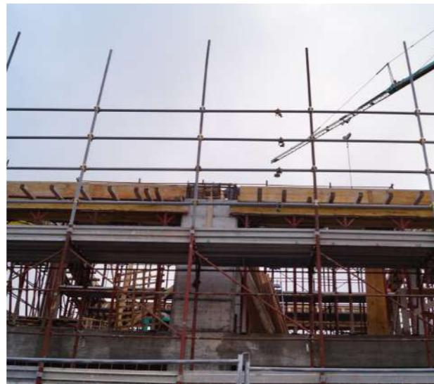
Foto 135 di Martina De Pasquale: 16 novembre 2019, edificio residenziale in costruzione a San Cipriano.
