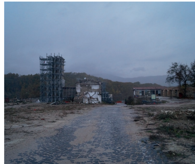
Foto 209 di Veronica Reale : 17 novembre 2019, edifici gravemente danneggiati nel centro storico.
