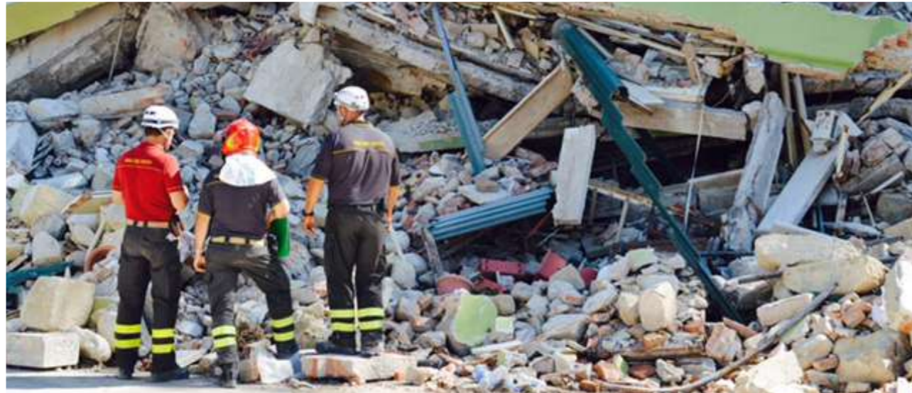
Foto 167: 6 settembre 2016, messa in sicurezza da parte della Protezione Civile (fonte:Libertà).
