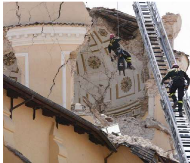
Foto 20: 2009, L'Aquila, danni al patrimonio culturale (fonte: improntaunika.it).
