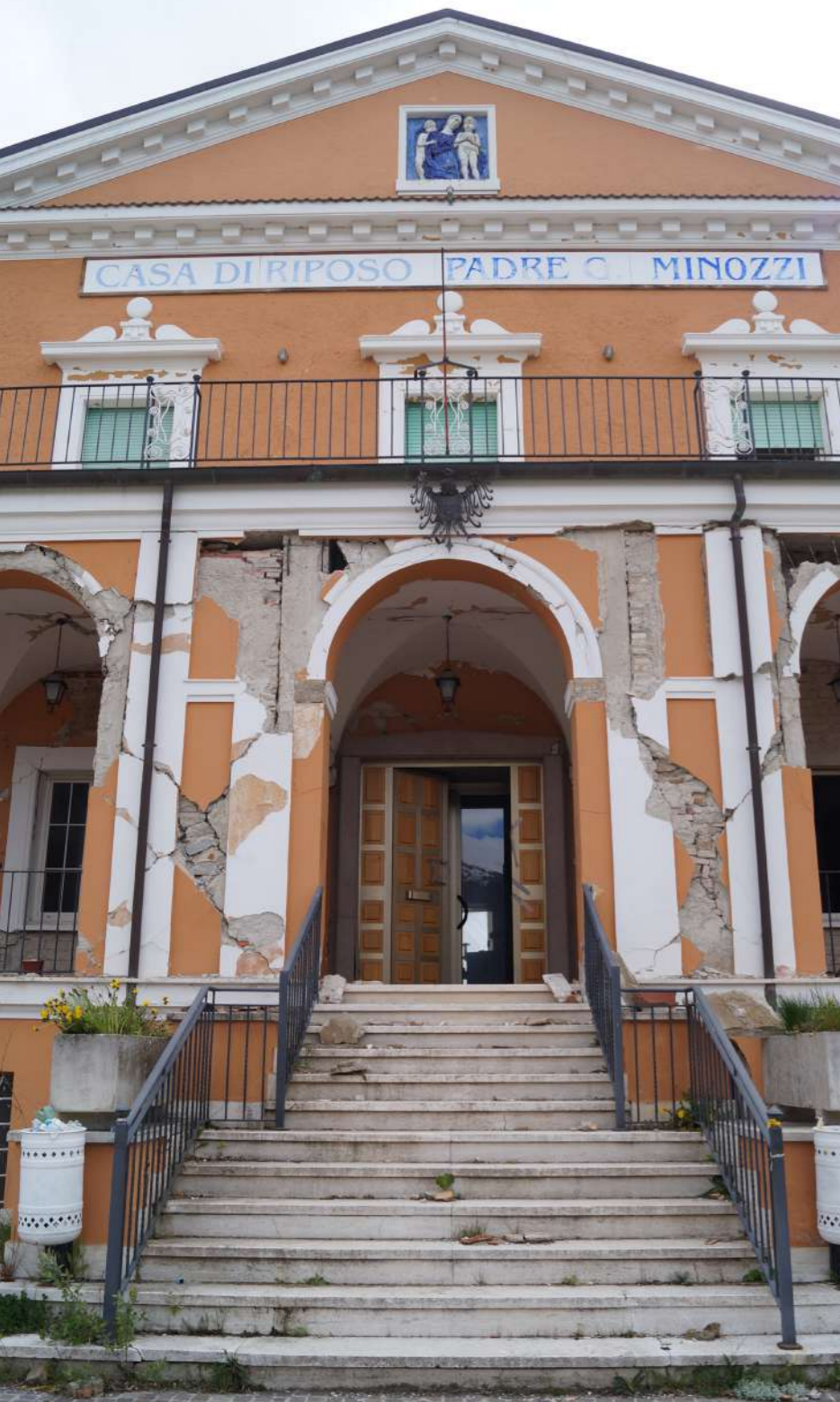
Foto 145 (a sinistra) di Elena Zocchi: 06 maggio 2019, ingresso principale ex Casa di riposo "Don Minozzi", dove si osserva la rottura a taglio delle murature portanti. Foto 146 (in alto) di Veronica Reale: 17 novembre 2019, abitazione distrutta nel centro storico.
