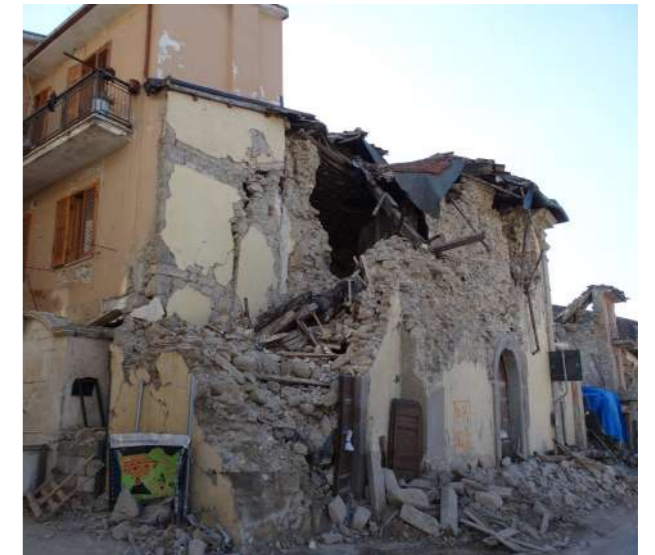
Foto 154 di Emma Moriconi: 26 marzo 2017, chiesa crollata nel centro storico.
