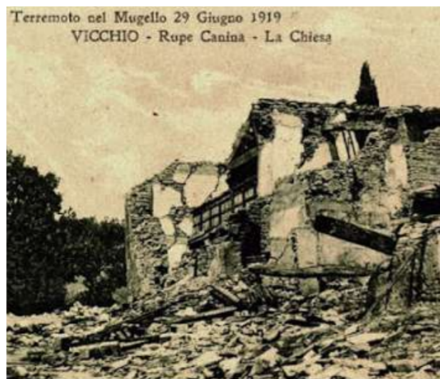
Foto 32: 29 giugno 1919, danni prodotti dal terremoto nel 1919 a Vicchio nel Mugello (fonte: Amici di Firenze).
