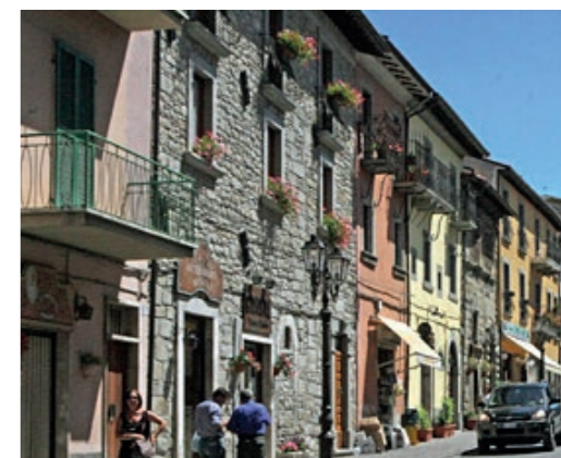
Foto 215 di Google Street View: 2011, vista laterale prospetti edifici su Corso Umberto I.
