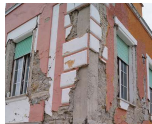
Foto 53 di Martina De Pasquale: 6 maggio 2019, dettaglio costruttivo dell'edificio.
