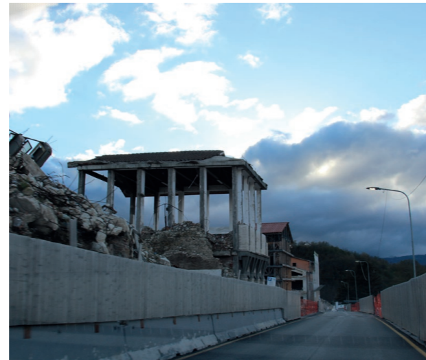
Foto 213 di Veronica Reale : 6 maggio 2019, edifici gravemente danneggiati nel Corso Umberto I.
