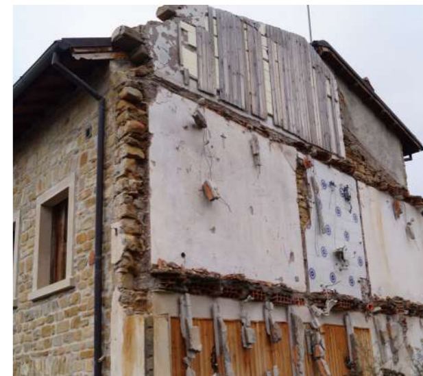
Foto 148 di Martina De Pasquale, 16 novembre 2019: crollo totale di un edificio in connessione ad uno sopravvissuto.
