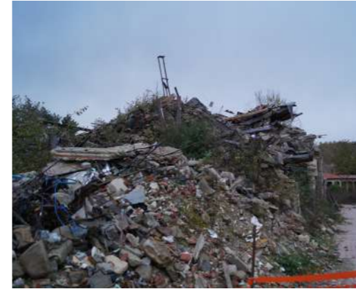
Foto 125 di Martina De Pasquale: 17 novembre 2019, macerie e detriti nel centro storico.
