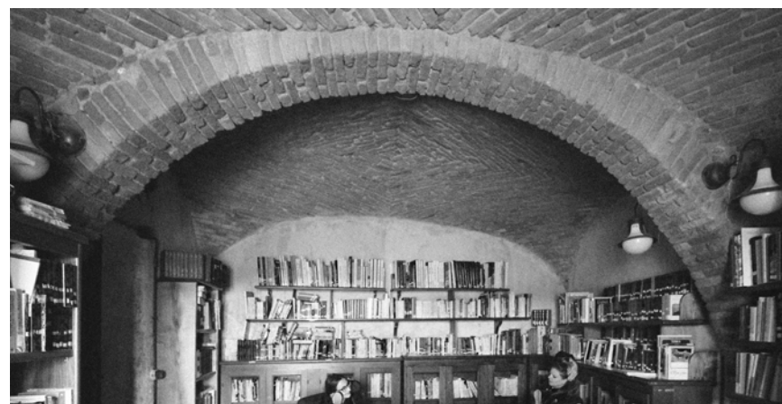
Vista del soffitto con volta a vela ribassata
