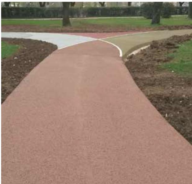
Immagine 5.1. Pavimentazione Drainbeton, esempio applicato.
