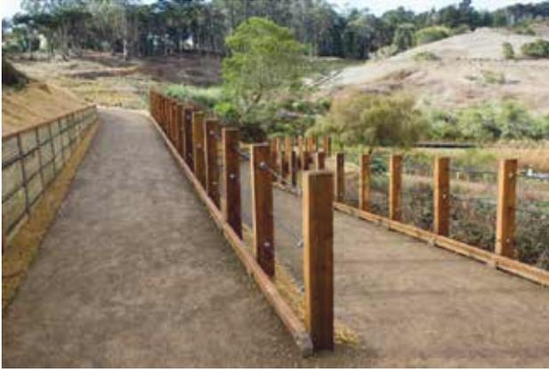
Immagine 6.1. Pavimentazione terra stabilizzata, esempio applicato.
