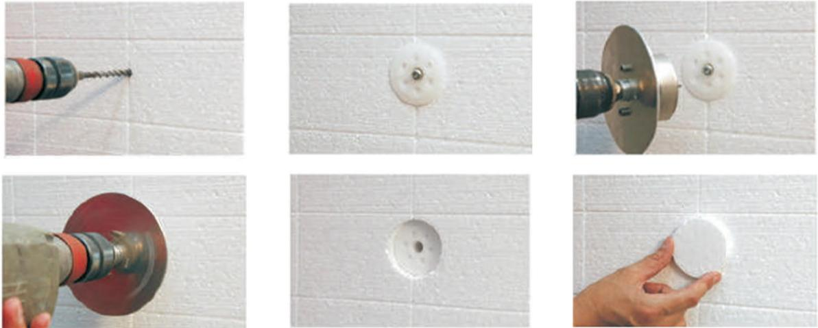
Figura 15. Esempio di fissaggio con tasselli a vite (da: Manuale di posa Waler 2016)
