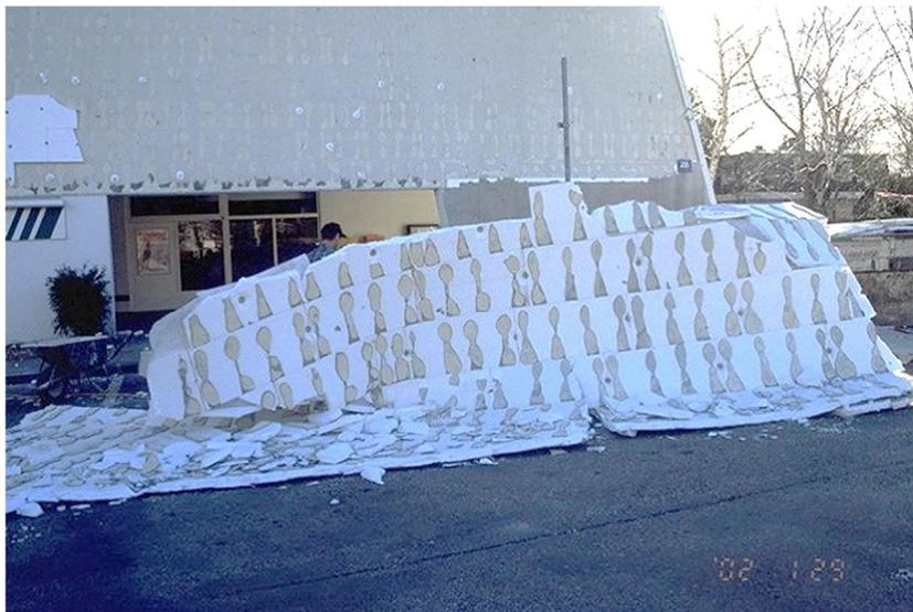
Figura 189. Distacco di cappotto per insufficiente adesione e tasselli inadeguati (da: Archivio Caparol 2015)
