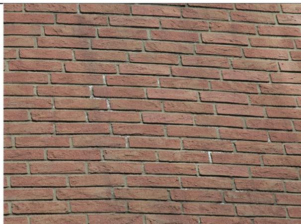
Figura 55. Ed.2 – Efflorescenze, presenza di sali
