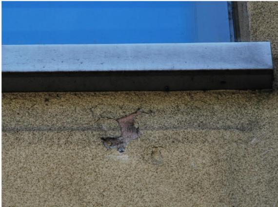
Figura 145. Ed.6 – Distacco con rete in evidenza
