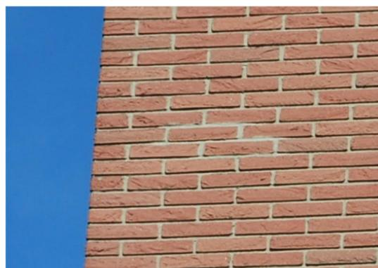
Figura 69. Ed.3 – Sostituzione localizzata
