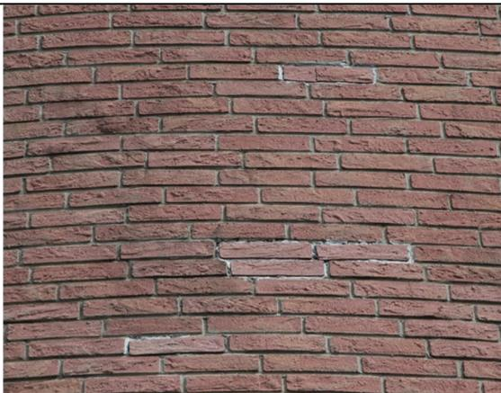
Figura 53. Ed.2 – Sostituzione localizzata mattoncini
