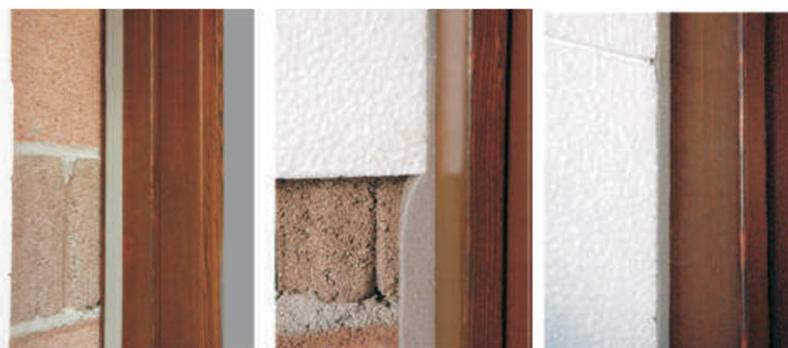
Figura 23. Raccordi con guarnizione precompressa (da: Manuale di posa Waler 2016)
