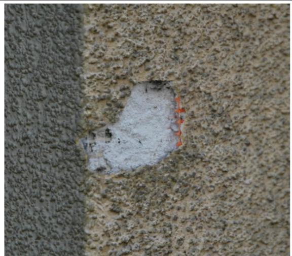
Figura 148. Ed.6 – Probabile urto con rete in evidenza
