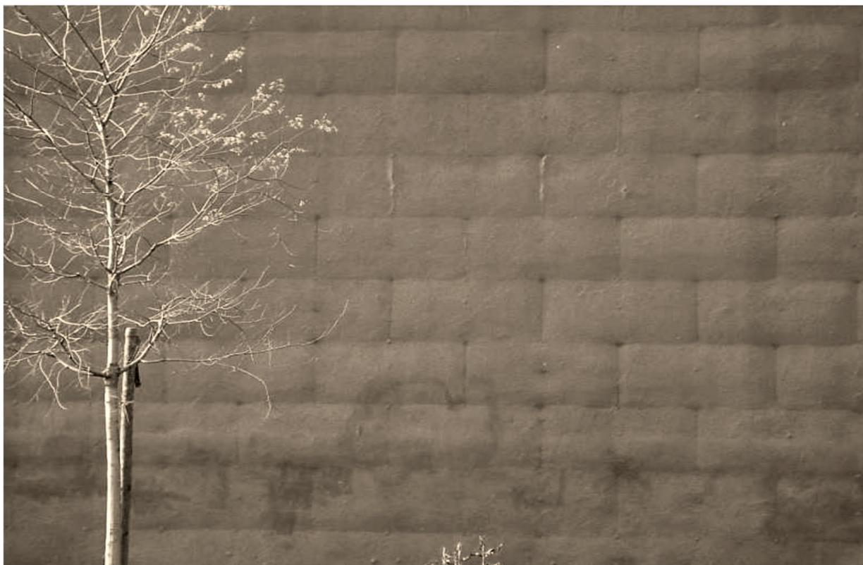
Figura 200. Effetti "materasso" causato da una procedura scorretta di incollaggio (da: Caparol 2016)
