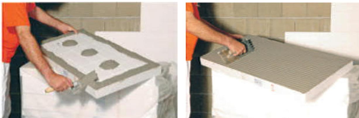
Figura 12. Esempio di applicazione dei pannelli (da: Manuale di applicazione Cortexa 2014)
