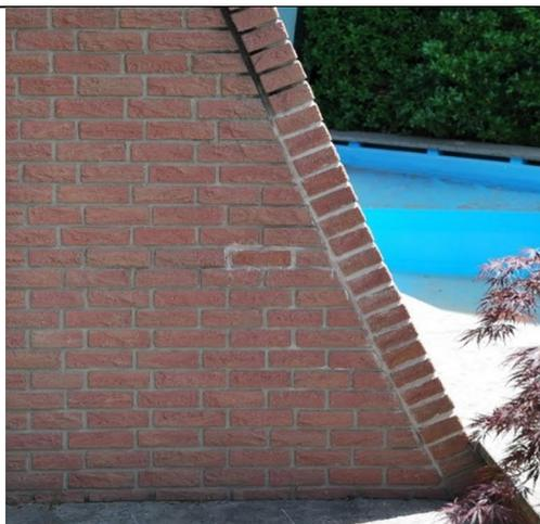
Figura 59. Ed.2 – Sostituzione parziale
