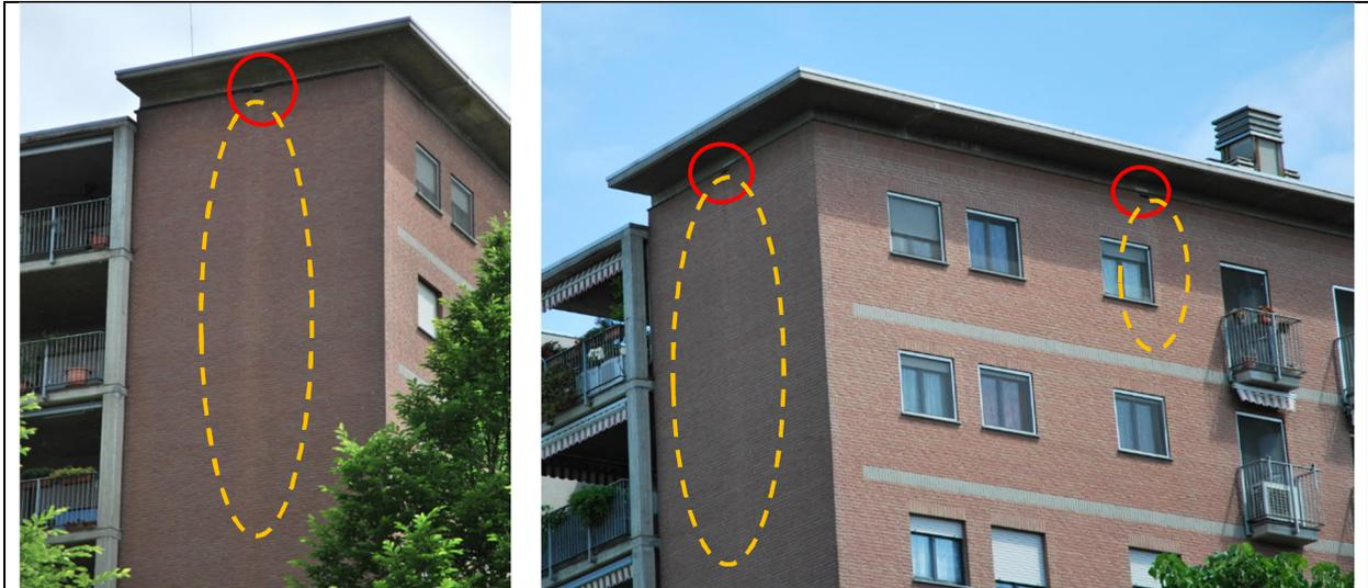
Figura 80. Ed.4 – Dilavamento in corrispondenza di aggetti localizzati in varie zone delle facciate
