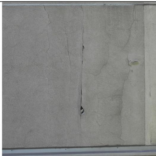
Figura 123. Ed.5 – Microfessurazioni e lesione verticale con distacco
