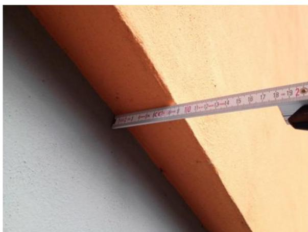
Figura 31. Ed.1 – Determinazione dello spessore di pannello utilizzato
