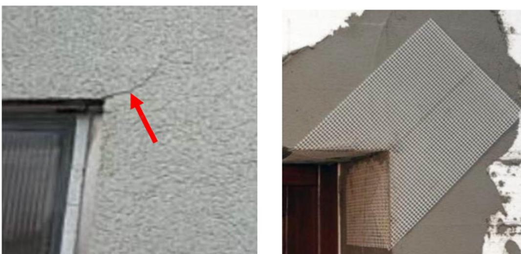
Figura 207. Lesione dello spigolo del serramento e rimedio con fazzoletti di rete (da: Caparol 2016)
