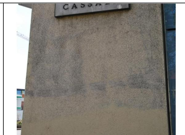
Figura 142. Ed.6 – Alterazione cromatica, depositi, Annerimenti
