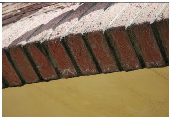
Figura 58. Ed.2 – Efflorescenze, presenza di sali
