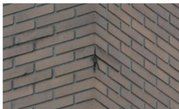
Figura 156. Ed.7 – Fessurazione in corrispondenza dello spigolo dell'edificio
