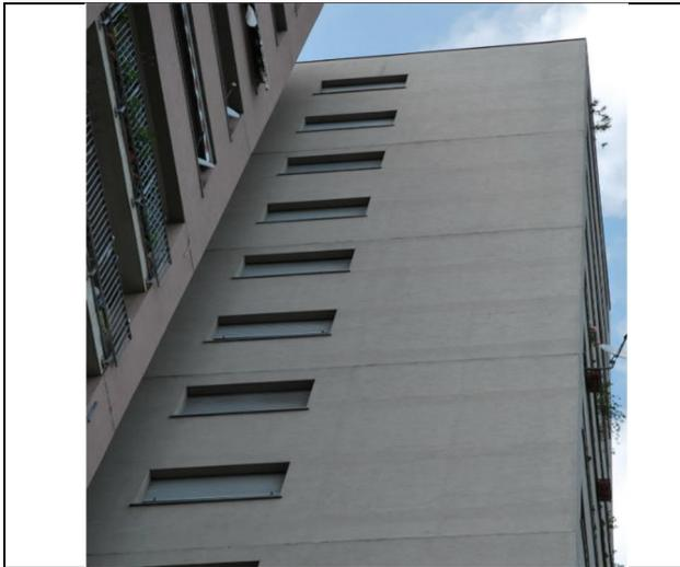
Figura 112. Ed.5 – Alterazione cromatica (da probabile sovrapposizione e ripresa di pittura)
