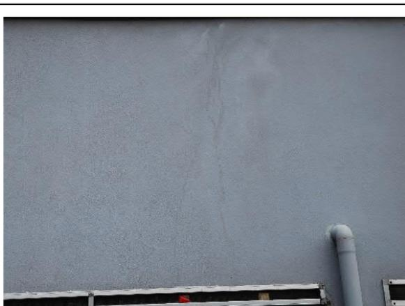
Figura 39. Ed.1 – fessurazione da infiltrazione
