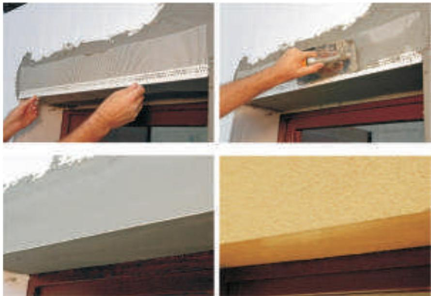
Figura 19. Realizzazione di bordi con gocciolatoio (da: Manuale di posa Waler 2016)
