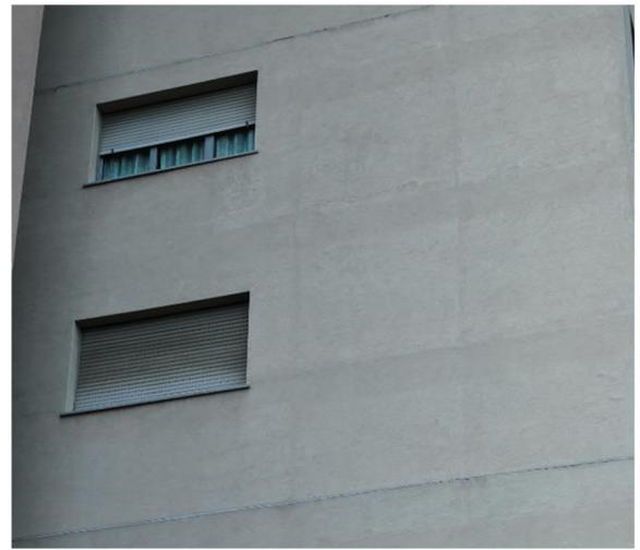
Figura 113. Ed.5 – Alterazione cromatica (da probabile sovrapposizione e ripresa di pittura)
