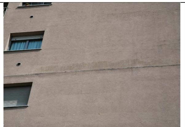
Figura 117. Ed.5 – depositi in corrispondenza dei giunti orizzontali
