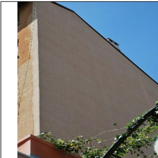
Figura 162. Ed.8 – Alterazioni cromatiche da rasatura imperfetta
