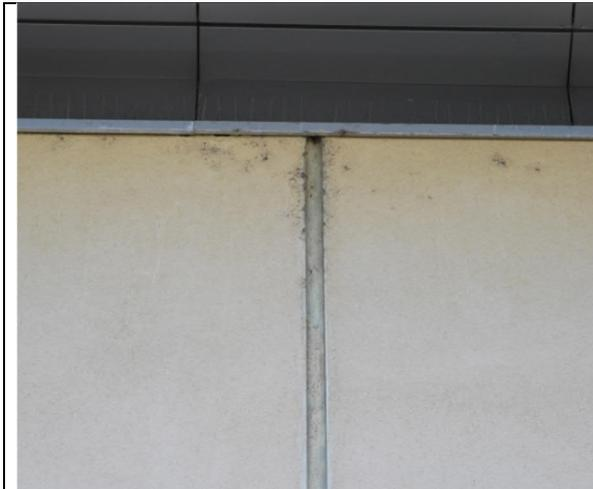
Figura 135. Ed.6 – Alterazioni cromatiche in corrispondenza del giunto verticale
