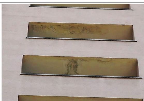
Figura 103. Ed.5 – Scrostamento Balconi
