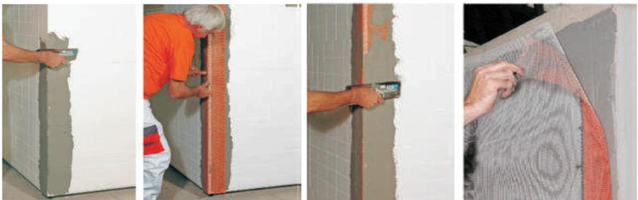
Figura 20. Realizzazione degli spigoli (da: Manuale di posa Waler 2016)
