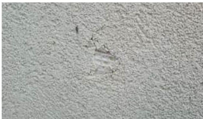
Figura 206. Rete a vista per effetto di mancanza di spessore di rasante (da: Caparol 2016)
