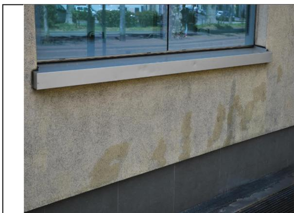
Figura 141. Ed.6 – Alterazione cromatica, depositi, Annerimenti
