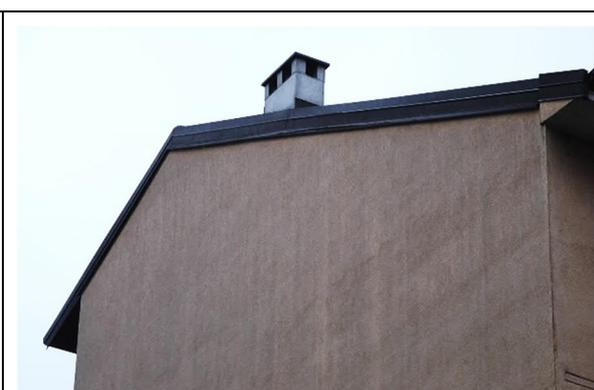
Figura 159. Ed.8 – Alterazioni cromatiche da rasatura imperfetta
