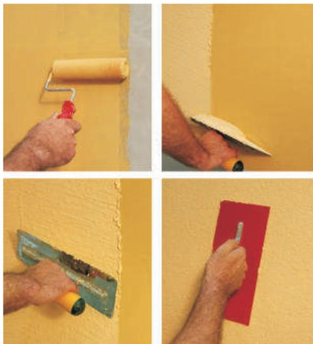
Figura 21. Realizzazione del rivestimento di finitura (da: Manuale di posa Waler 2016)
