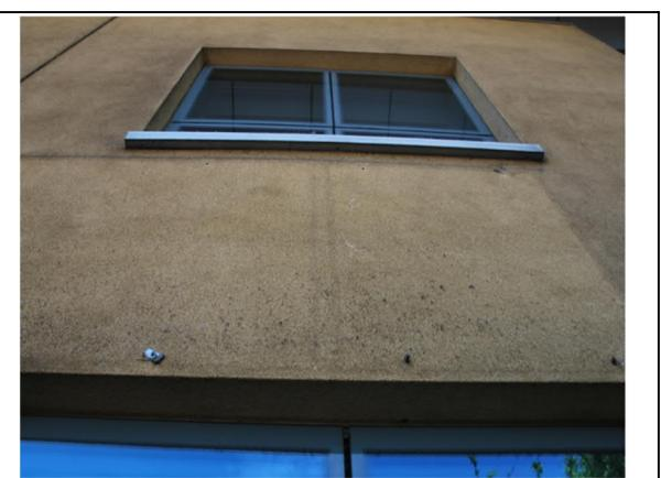
Figura 144. Ed.6 – Alterazione cromatica e depositi
