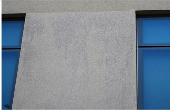
Figura 129. Ed.6 –Variazione cromatica e depositi
