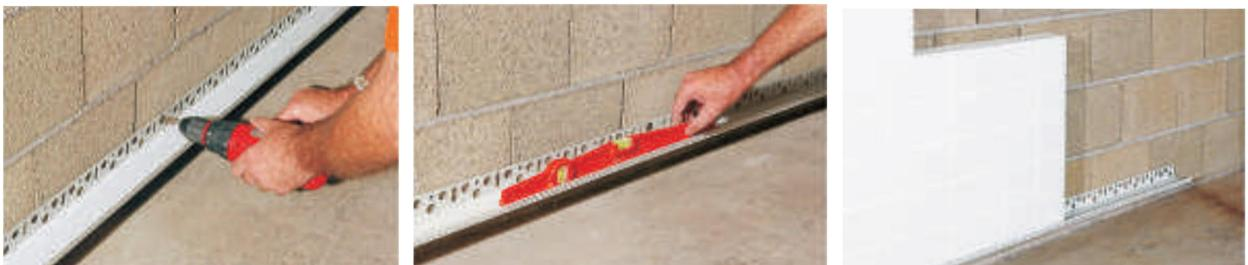
Figura 11. Esempio di posa della zoccolatura (da: Manuale di applicazione Cortexa 2014)
