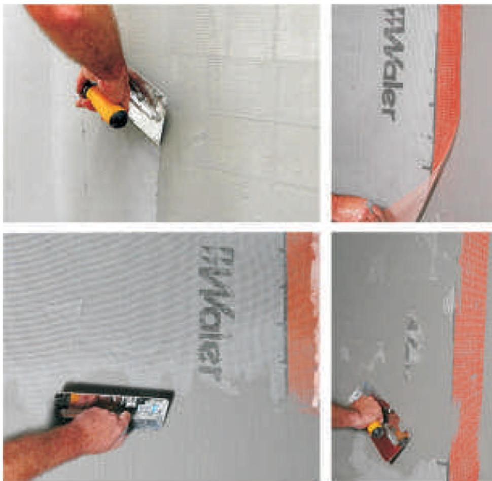
Figura 17. Applicazione della rete di armatura (da: Manuale di posa Waler 2016)
