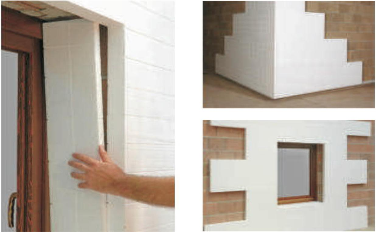
Figura 13. Applicazione in corrispondenza di spigoli e finestre (da: Manuale di applicazione Cortexa 2014)
