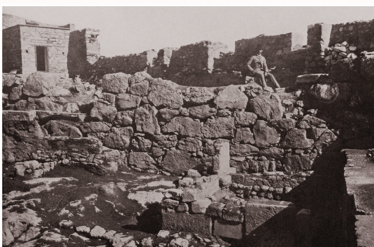
Vista muro perimetrale Est e Laboratorio
