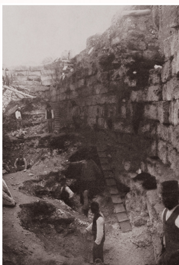
Mura Sud, vista da Ovest verso Est
