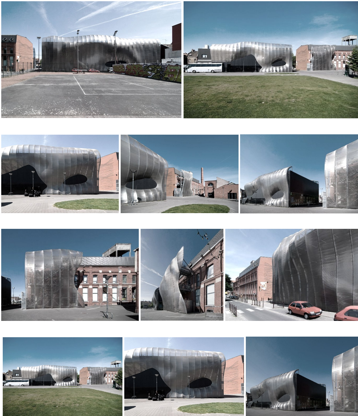
Figure 9: Maison Folie de Wasemmes Images, Photo Credits: https://www.archiweb.cz/en/b/maison-folie-de-wazemmes
