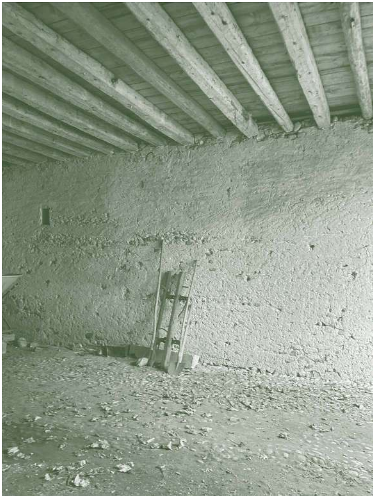
La rimessa al piano terra. Foto dell'autore.
