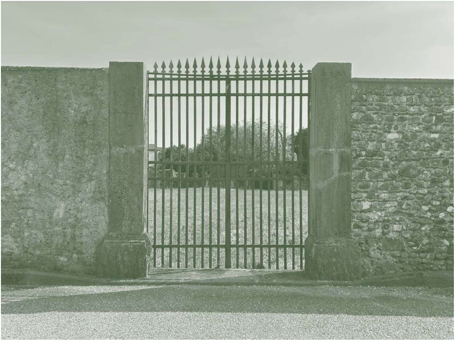
Il cancello di ingresso. Foto dell'autore.
