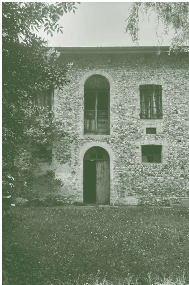
L'ingresso principale alla stalla dalla corte. Foto dell'autore.
