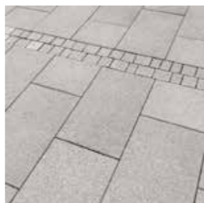
Pavimentazione in lastre di cls
