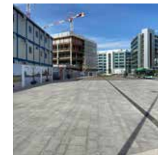
Figura 17. Cantiere “Spark2” e edifici Sky
