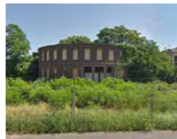
Figura 21. Palazzina ex chimici
