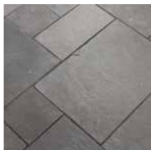
Pavimentazione in lastre di granito
