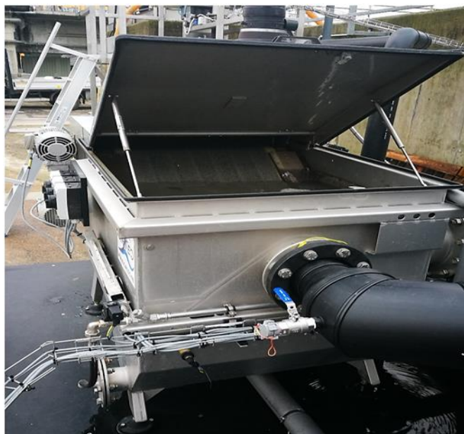
(3): Filtro a nastro rotante tipo Salsnes SF 2000.
