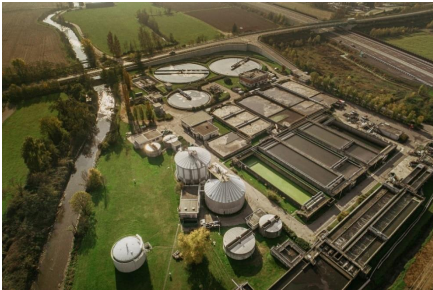
Figura 2.1. L'impianto di depurazione di Truccazzano (gruppo CAP).
