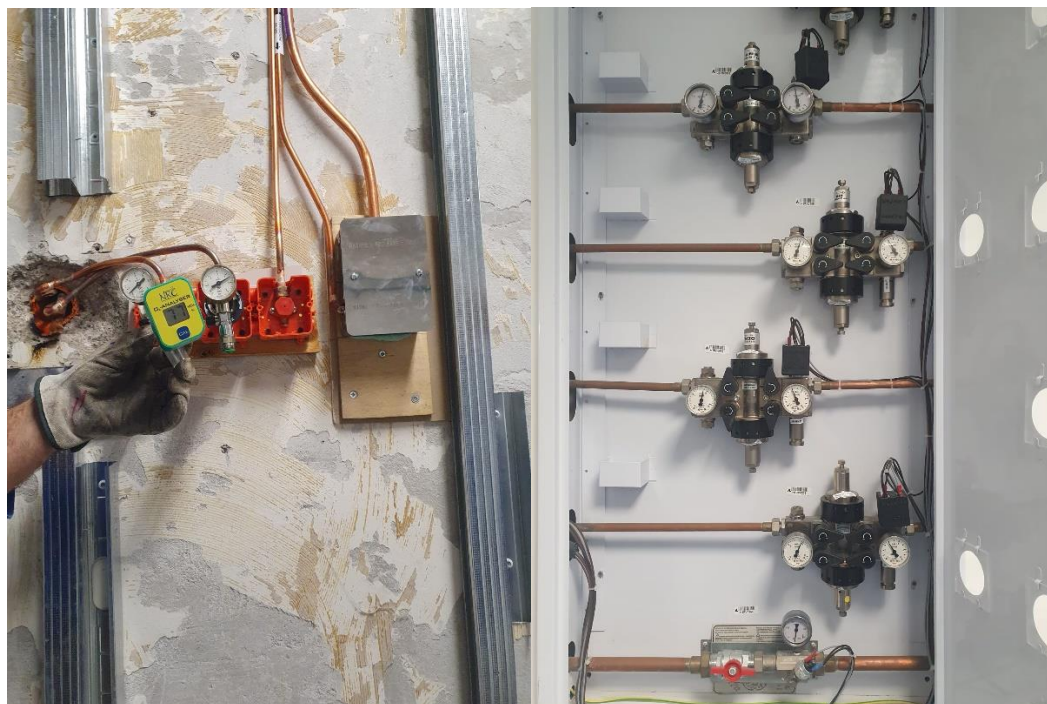
Figura 1.20: Prova delle perdite di una nuova installazione
