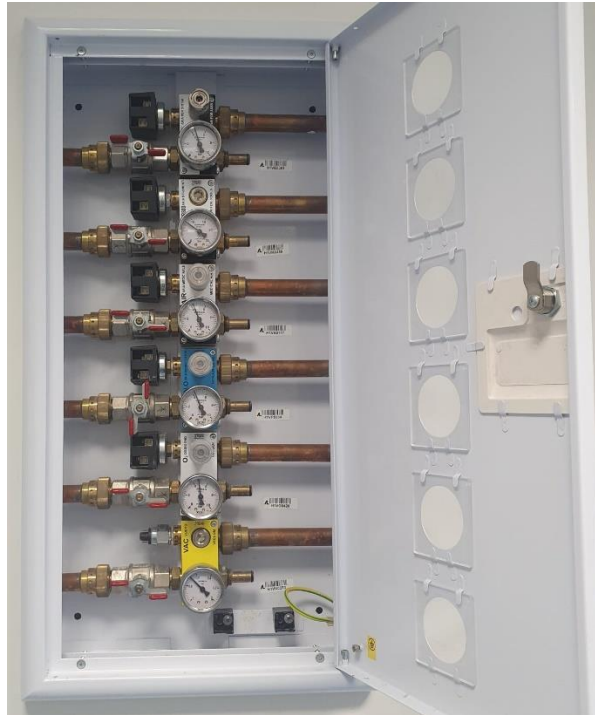
Figura 1.21: Riduttori di pressione
