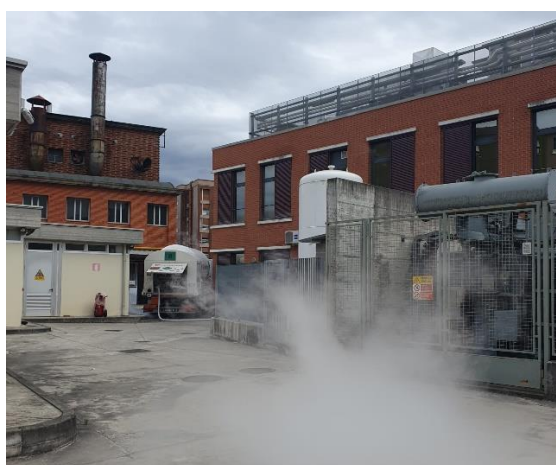
Figura 1.15 (a): Rifornamento da autocisterna
