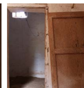
fig. 1.1.To0.3 - J.Zatti, Mass. Borzone, Porta interna della torre
