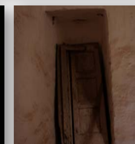
fig. 1.1.To1.5 - J.Zatti, Mass. Borzone, Ripostiglio piano primo
