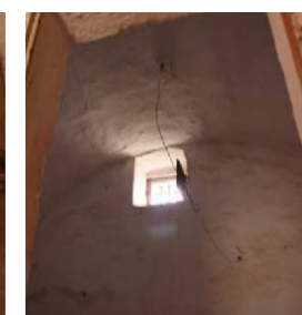
fig. 1.1.To0.4 - J.Zatti, Mass. Borzone, Finestra al piano terra della torre
