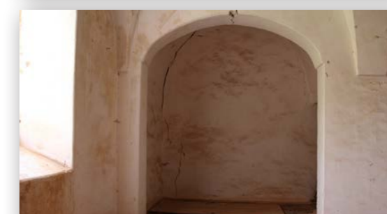
fig. 1.1.To1.7 - J.Zatti, Mass. Borzone, Vista interna 02 piano primo
