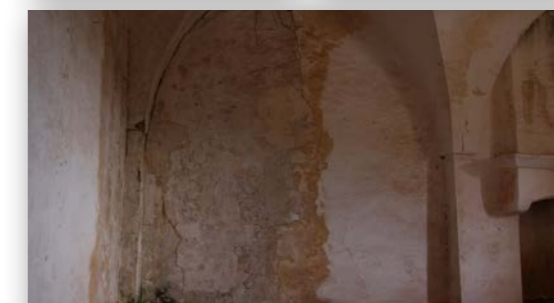
fig. 1.1.To1.3 - J.Zatti, Mass. Borzone, Vista interna 01 piano primo
