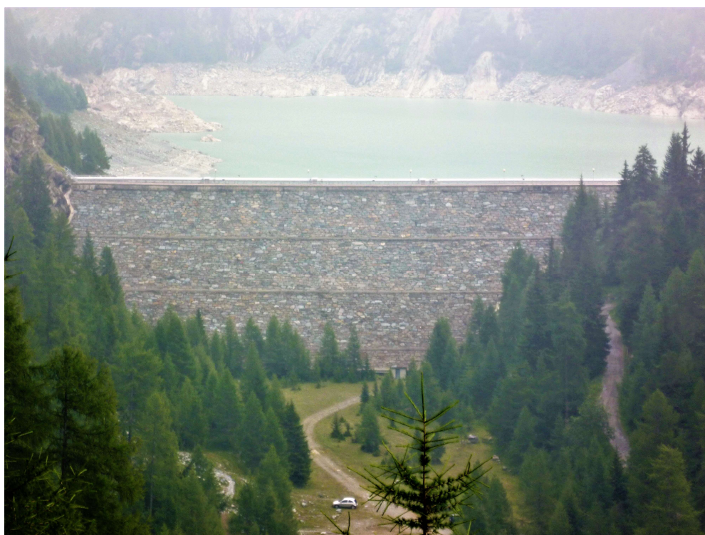
Figura 11: Diga Ovest, in pietrame, del serbatoio di Campo Moro. Foto scattata dal sentiero che porta all'alpe Musella
