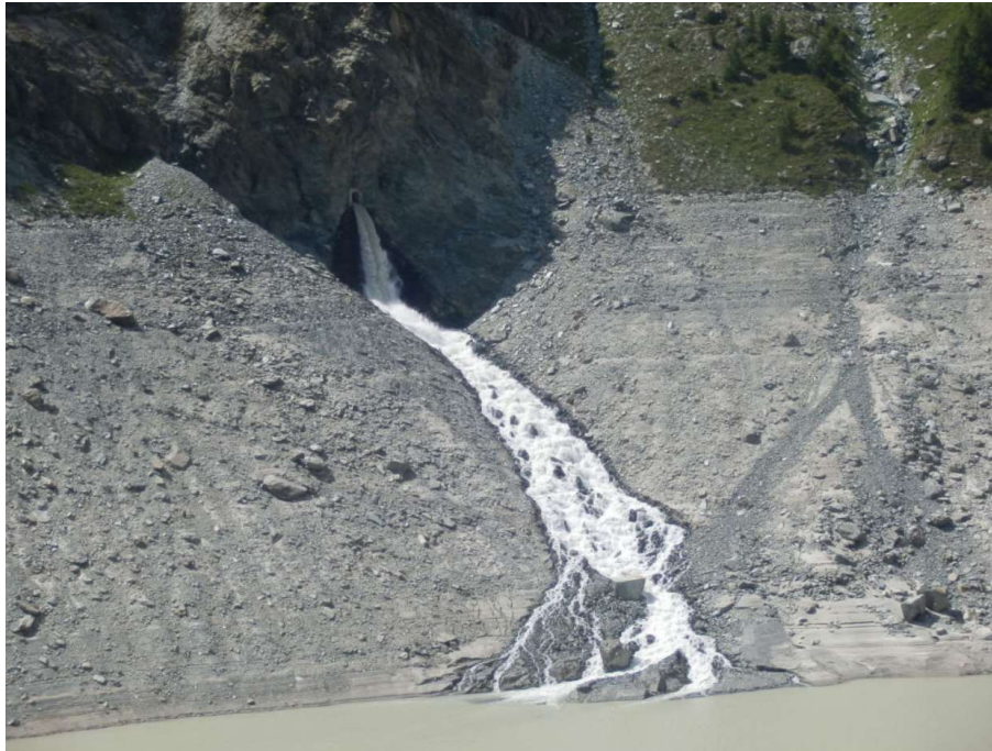
Figura 12: Lo sbocco dell'opera di presa che porta le acque dal ghiacciaio dello Scerscen al bacino di Alpe Gera.
