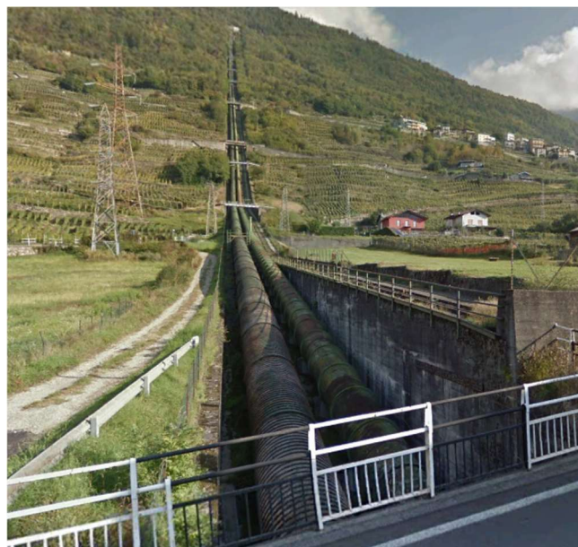
Figura 8: Condotte forzate a Sondrio che portano l'acqua della Valmalenco direttamente nell'Adda
