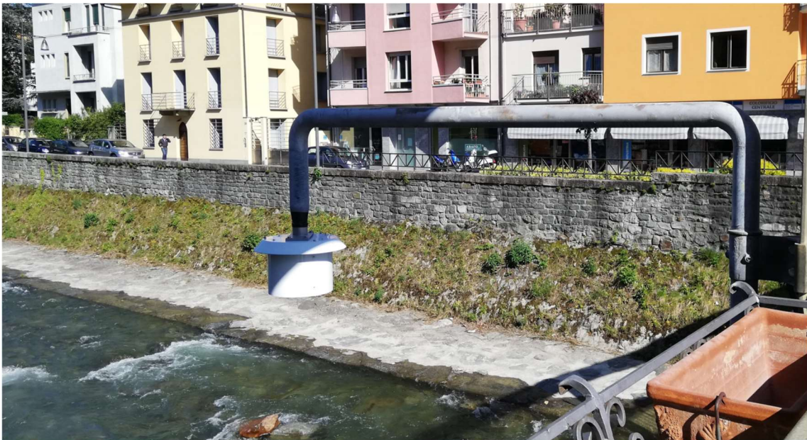
Figura 16: Idrometro ad ultrasuoni posto sul ponte Eiffel a Sondrio per la misura del livello idrico del torrente Mallero
