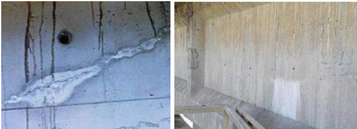
Figura 3.9: Lesione su anima lungo il tracciato dei cavi, immagini tratte da [14].
