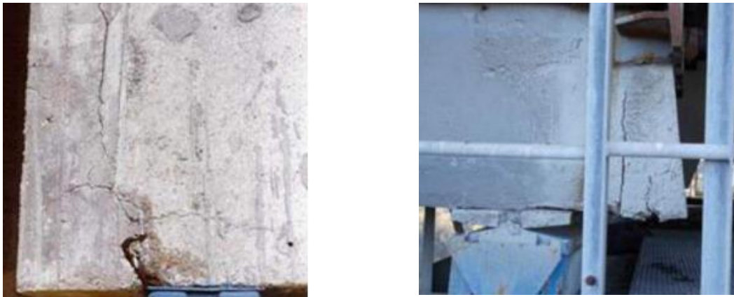
Figura 3.8: Distacco tamponi testate, immagini tratte da [14].
