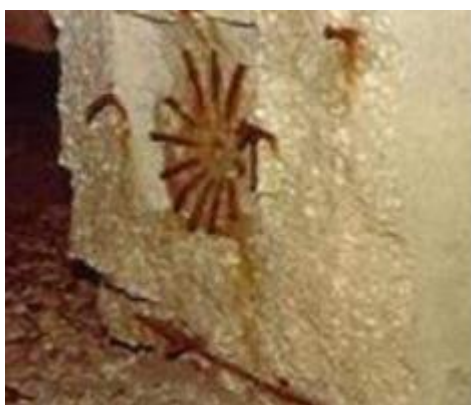
Figura 3.7: Testate di ancoraggio non sigillato, immagini tratte da [14].
