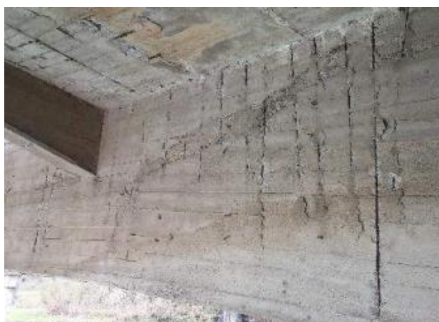
Figura 3.6: Riprese successive deteriorate, immagine tratta da [14].
