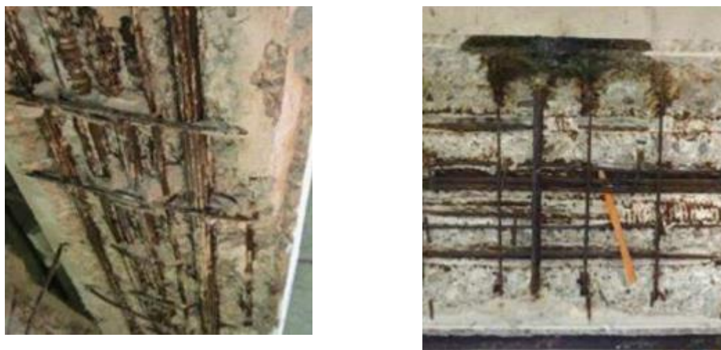
Figura 3.3: Guaine degradate e fili ossidati, immagini tratte da [14].
