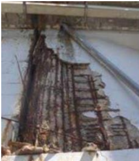
Figura 3.13: Armatura scoperta/ossidata nelle testate, immagini tratte da [14].
