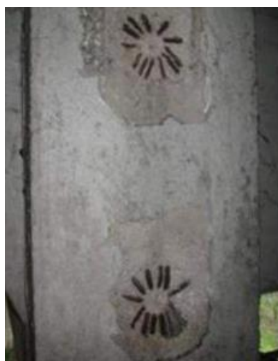
Figura 3.7: Testate di ancoraggio non sigillato, immagini tratte da [14].
