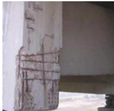
Figura 3.13: Armatura scoperta/ossidata nelle testate, immagini tratte da [14].
