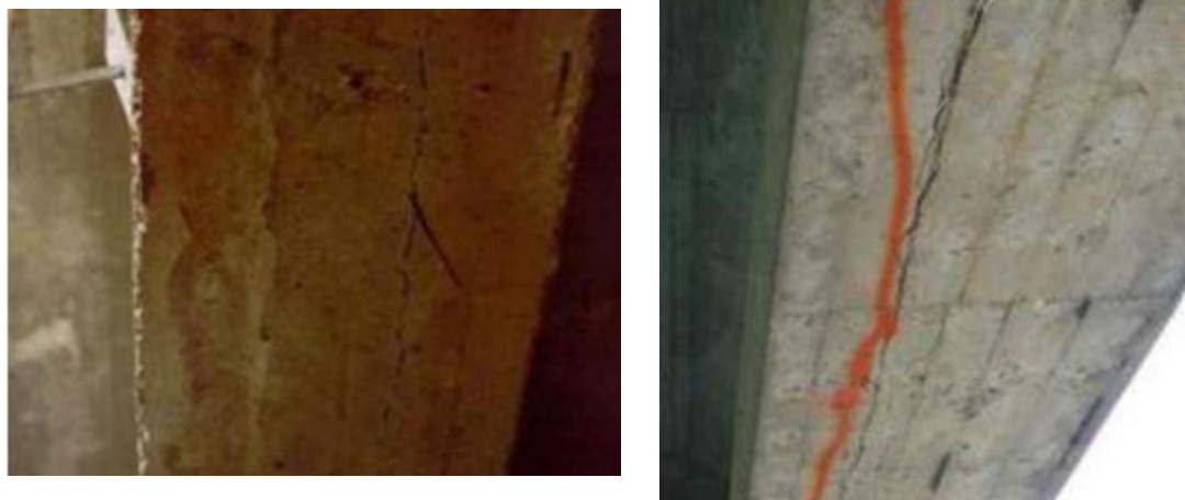
Figura 3.10: Lesione su suola del bulbo, immagini tratte da [14].
