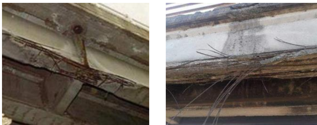
Figura 3.4: Riduzione armatura di precompressione, immagini tratte da [14].
