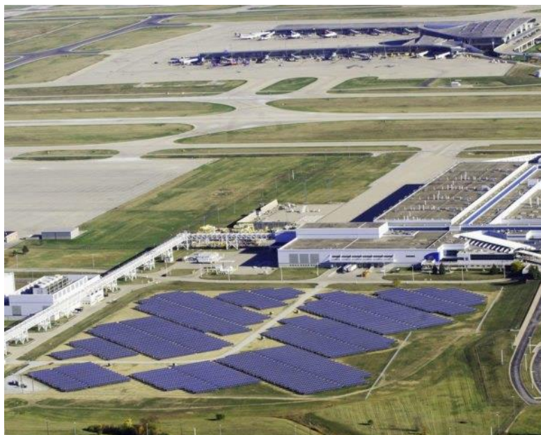
Figura 1.14: Installazione fotovoltaica situata nell'aeroporto di Minneapolis, USA.
