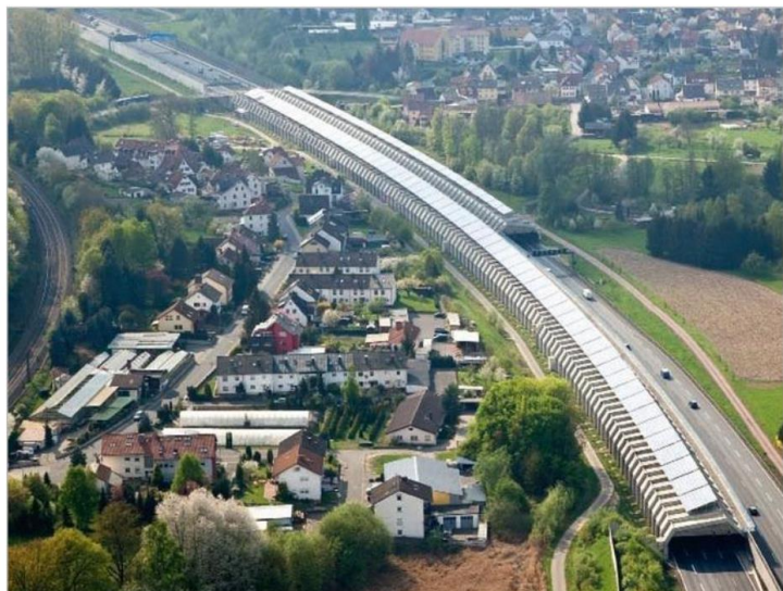
Figura 1.5: Impianto solare sul tetto del tunnel barriera antirumore nei pressi di Aschaffenburg, Germania (U.S. DOT, 2012).
