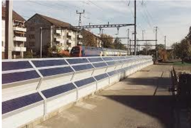
Figura 1.11: PVNB lungo la linea ferroviaria a Zurigo (Nordmann e Clavadetscher, 2004).
