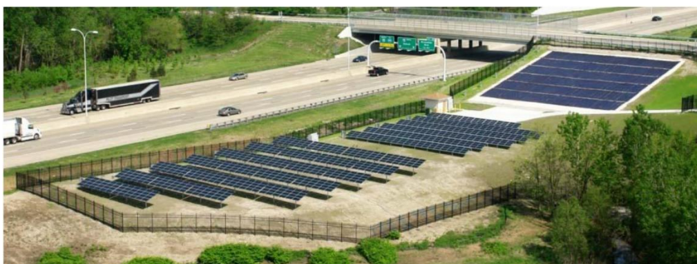
Figura 1.3: Campo fotovoltaico installato lungo un tratto autostradale a Toledo, Ohio (Stuart e Phillips, 2012).
