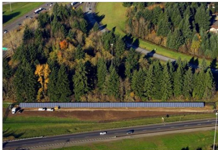
Figura 1.2: Array fotovoltaico installato nell'area confinante con l'autostrada in Oregon.
