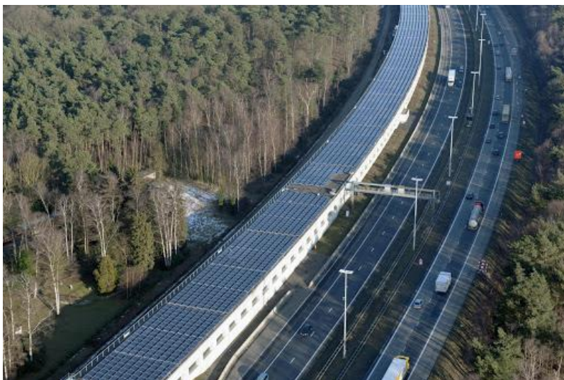
Figura 1.12: Tunnel coperto da pannelli solari sulla tratta ferroviaria Amsterdam-Parigi, Belgio.
