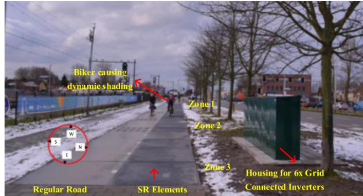
Figura 1.8: Pista ciclabile fotovoltaica installata in Olanda (Shekhar et al., 2018).
