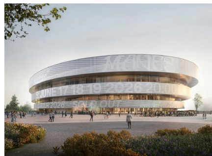
Figura III.1.19. Render esterno Palaitalia Fonte immagine: D. Chipperfield Architects
