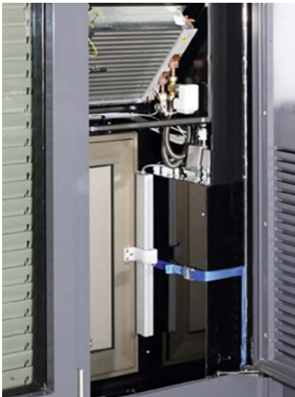
Figura VI.1.15. Facciata con ventilazione decentralizzata Fonte immagine: TEmotion-Module
