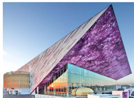
Figura III.1.11. Sud de France Arena
