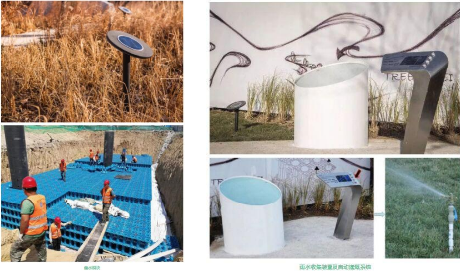
雨水收集装置及自动灌溉系统
