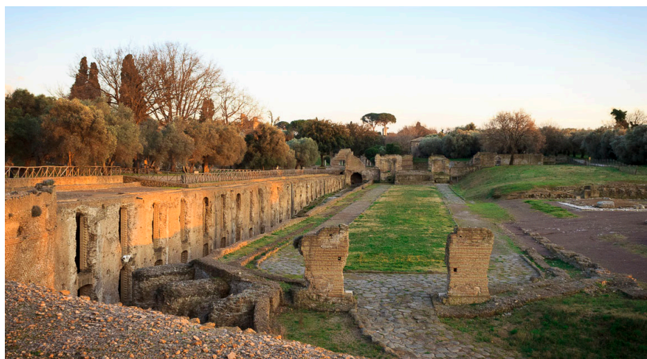
Vista attuale delle Cento Camerelle e del Grande Vestibolo, Villa Adriana, Tivoli
