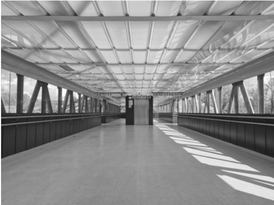
Fig. 158 The new overpass
