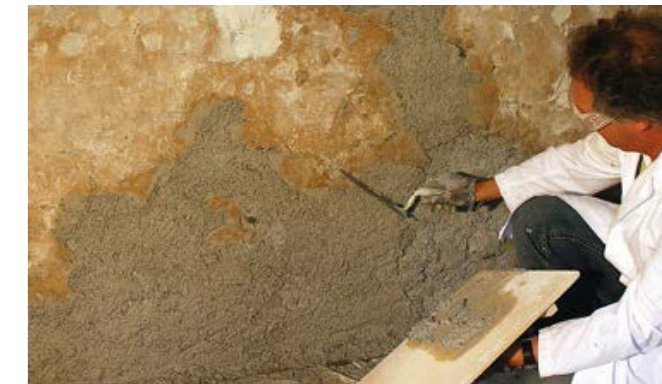
fig. 11.6.1 Operazioni di rimozione dell'intonaco ammalorato e ripristino del nuovo
