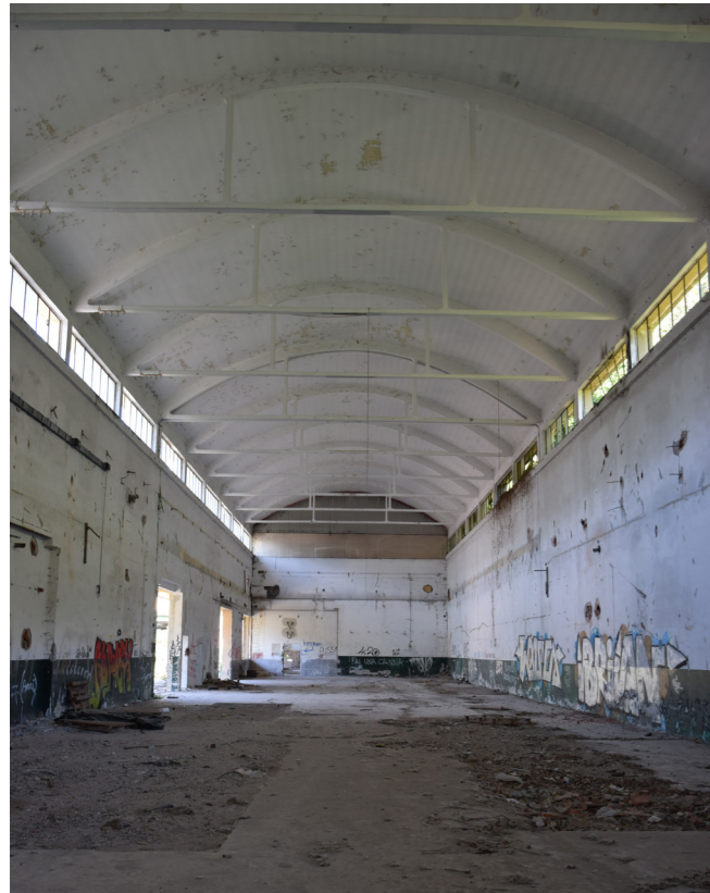
fig. 4.24 Foto dell'interno dell'edificio allo stato di fatto da cui si può apprezzare la forma della reticolari che sostengono la copertura e la pianta libera garantita dalla struttura portante e dalla forma allungata del copro di fabbrica, foto nostra.
