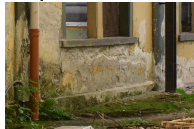
fig. 9.3.1 Lacuna intonaco, foto nostra
