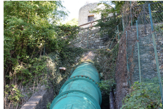
fig. 7.10.12 Conduittura acquedotto, foto nostra
