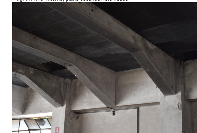
fig. 7.14.11 Dettaglio travi, piano secondo, foto nostra
