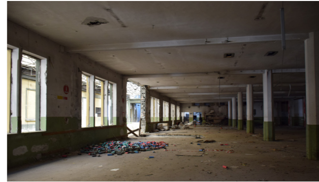
fig. 10.18.2 Solaio, Edificio 9, foto nostra
