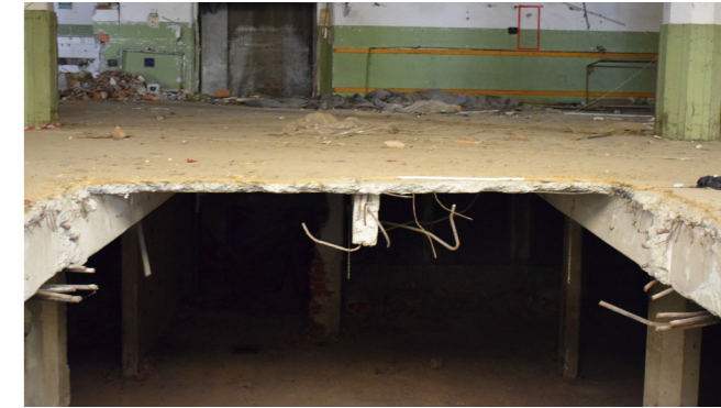
fig. 10.19.2 Solaio, Edificio 9, foto nostra
