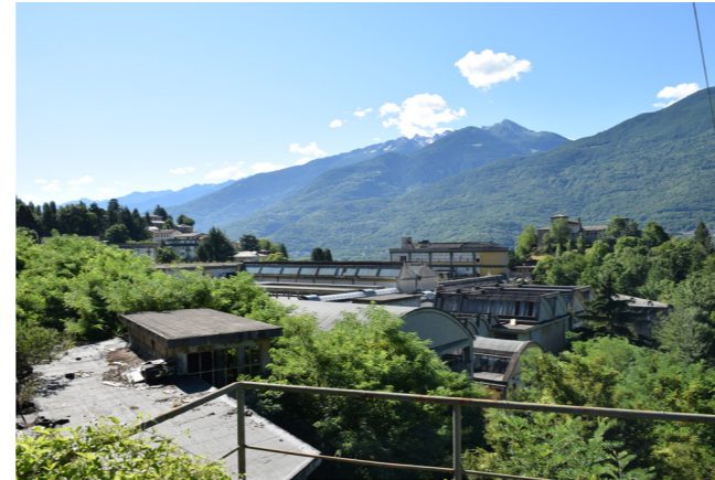
fig. 7.20.10 Esterno, vista dalla turbina, foto nostra
