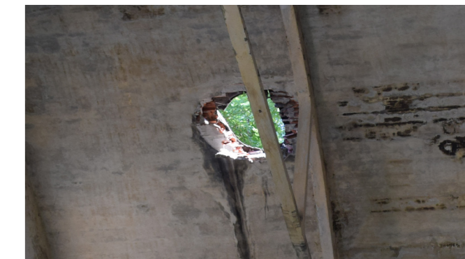
fig. 10.15.3 Copertura, sezione ovest Edificio 19, foto nostra
