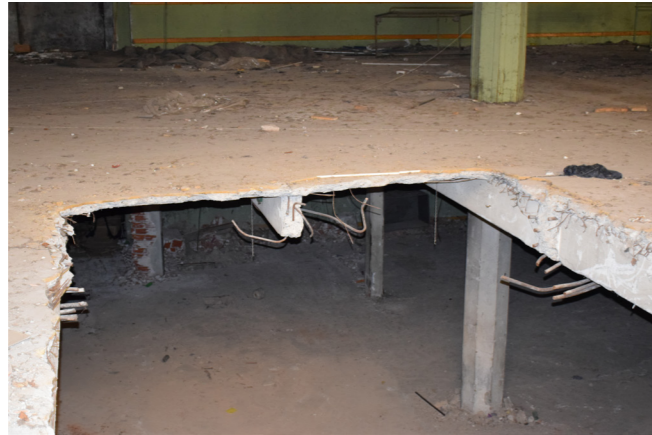
fig. 7.9.7 Dettaglio solaio, foto nostra
