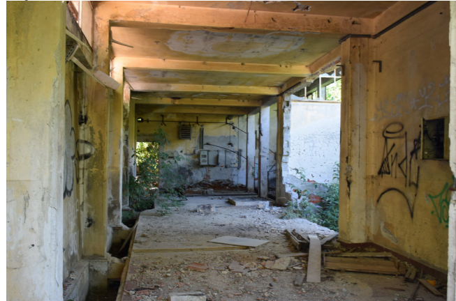
fig. 7.20.5 Cabina di trasformazione, foto nostra
