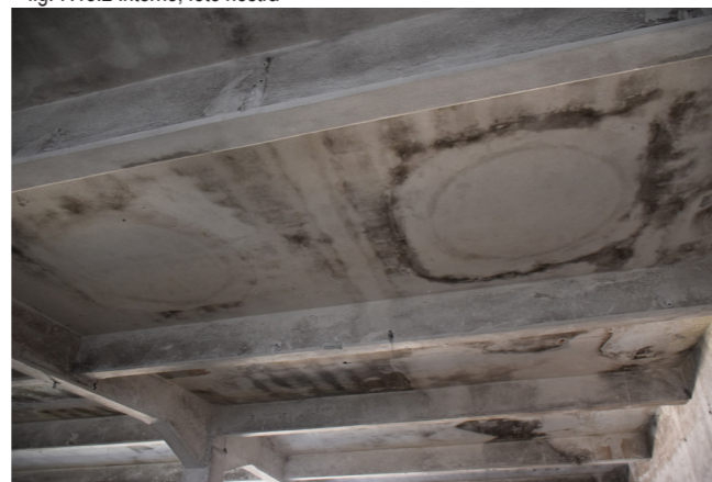
fig. 7.15.3 Dettaglio solaio, foto nostra
