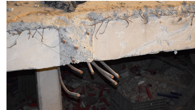
fig. 10.19.3 Solaio, Edificio 9, foto nostra
