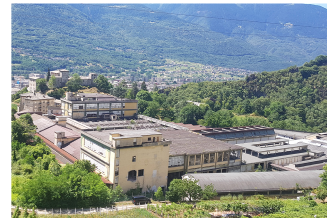
fig. 4.10 Vista dal sentiero Rusca passante sopra il lotto, foto nostra
