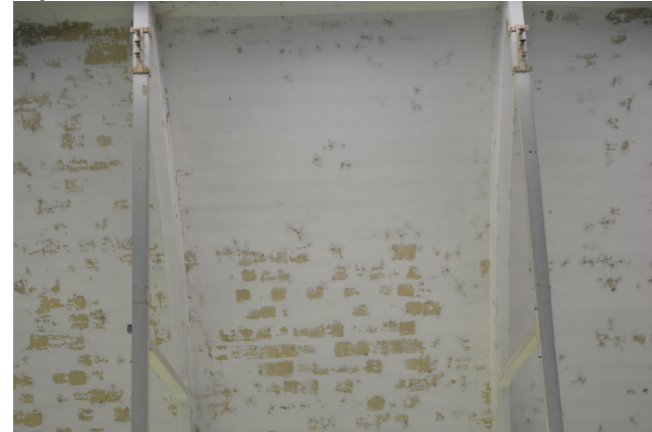
fig. 7.19.8 Dettaglio copertura, foto nostra
