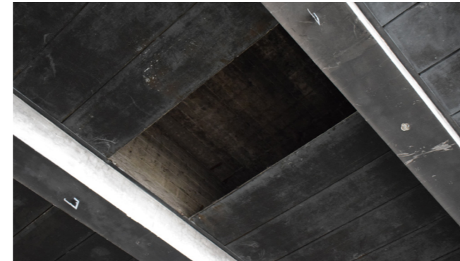
fig. 10.20.3 Solaio, Edificio 14, foto nostra
