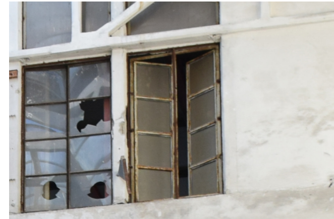
fig. 9.7.1 Ossidazione, foto nostra
