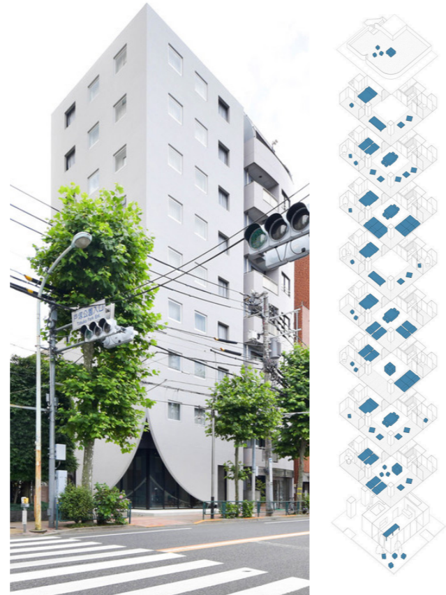
fig. 7.2 Alcune immagini della Lighthouse Tokyo in cui si può comprendere il sistema di suddivisione interna degli spazi
