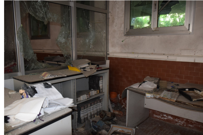
fig. 7.16.8 Interno, area uffici, foto nostra
