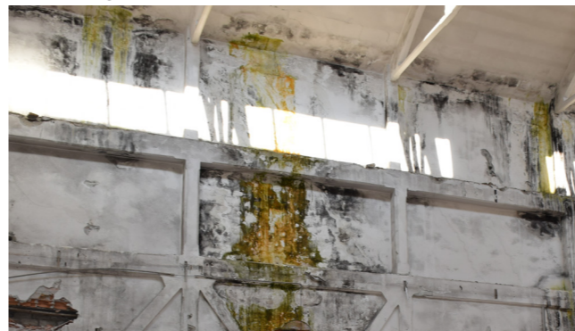
fig. 10.2.1 Parete ovest, Edificio 16, foto nostra
