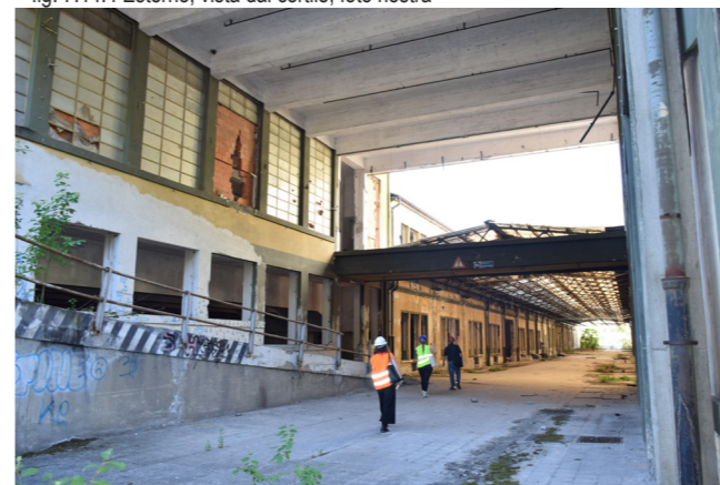
fig. 7.14.5 Esterno, vista dal cortile, foto nostra
