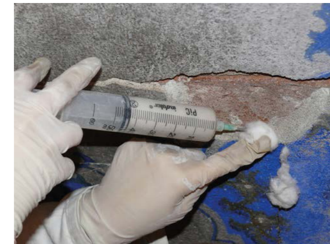
fig. 11.4.1 Iniezione di consolidamento
