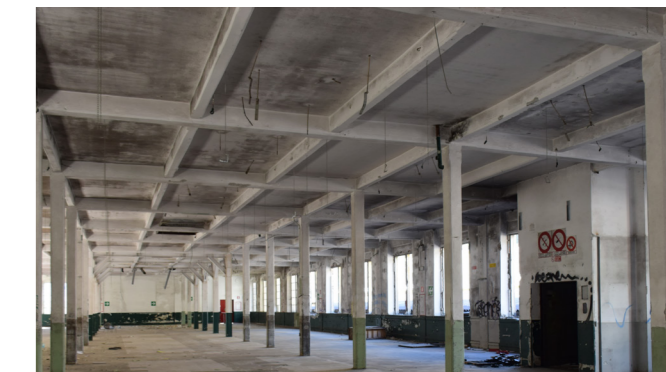
fig. 10.17.3 Solaio Edificio 8, foto nostra
