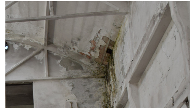
fig. 10.12.3 Copertura, Edificio 16, foto nostra
