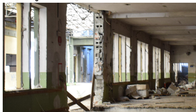
fig. 10.8.1 Parete ovest, Edificio 9, foto nostra
