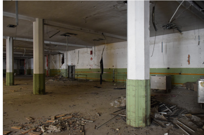
fig. 7.9.5 Interno, piano terra, foto nostra
