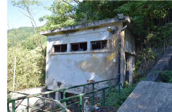
fig. 7.20.2 Turbina, foto nostra
