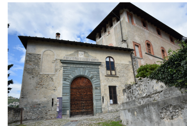
fig. 6.4 Ingresso a Castel Masegra, foto nostra
