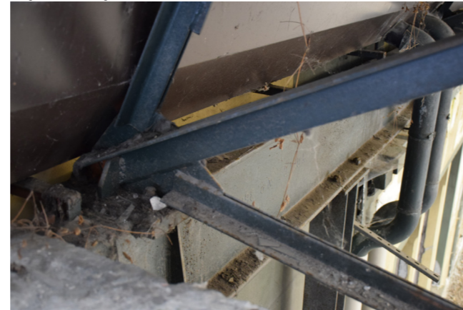
fig. 7.7.8 Dettaglio struttura metallica, foto nostra
