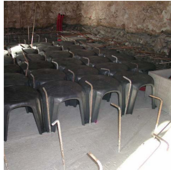
fig. 11.5.1 Foto degli elementi cupolari in fase di posa
