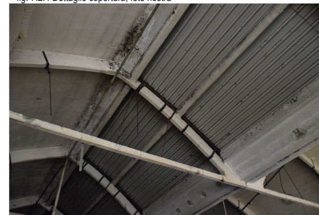
fig. 7.2.5 Dettaglio copertura, foto nostra
