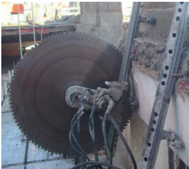
fig. 11.3.1 Taglio di una muratura per mezzo di sega circolare
