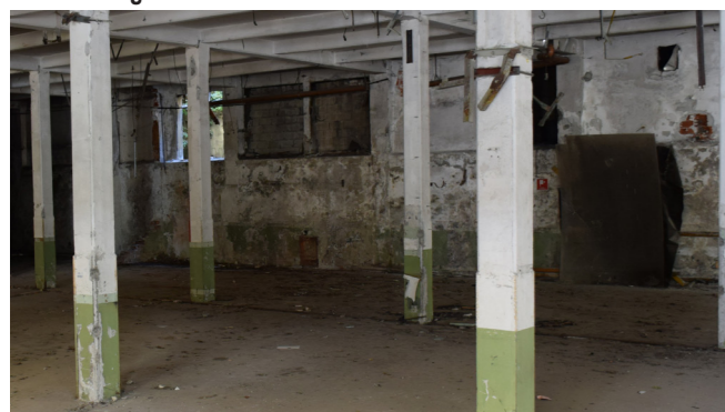
fig. 10.6.1 Parete est, Edificio 9, foto nostra
