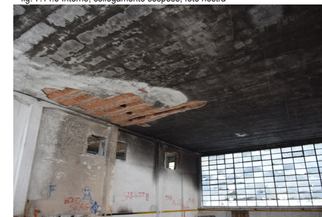
fig. 7.14.9 Dettaglio solaio, foto nostra
