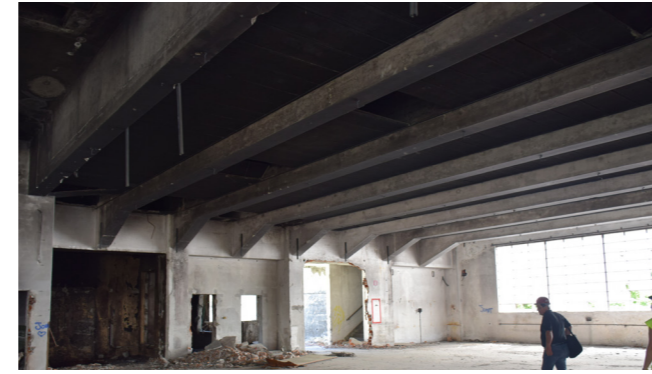
fig. 10.20.2 Solaio, Edificio 14, foto nostra
