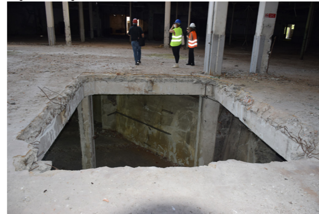
fig. 7.5.6 Dettaglio solaio, foto nostra
