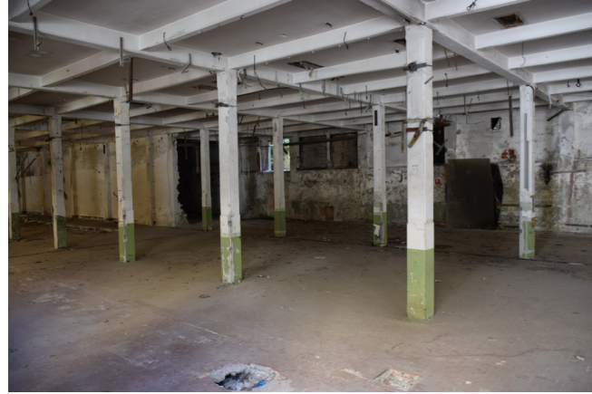
fig. 7.8.4 Interno, piano terra, foto nostra
