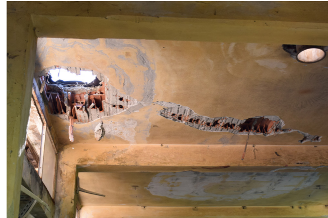
fig. 7.20.7 Dettaglio solaio, foto nostra
