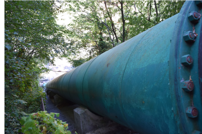
fig. 7.20.11 Conduittura acquedotto, foto nostra
