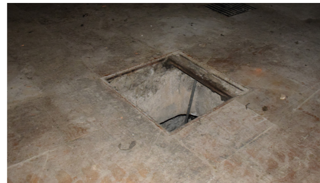
fig. 10.16.2 Pavimento, Edificio 2, foto nostra
