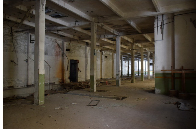
fig. 7.8.5 Interno, piano terra, foto nostra
