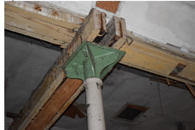
fig. 7.3.3 Dettaglio pilastro, foto nostra
