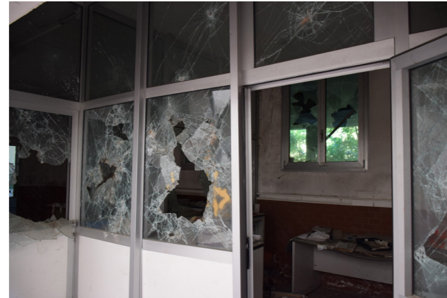
fig. 7.16.7 Interno, area uffici, foto nostra
