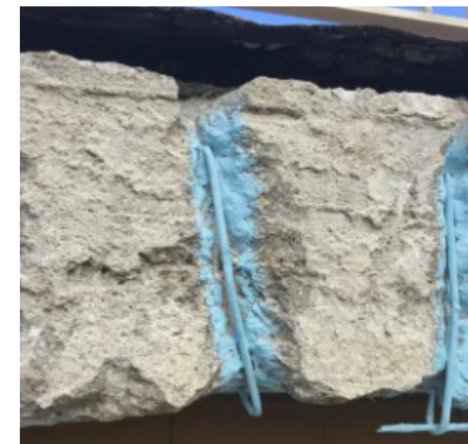
fig. 11.8.1 Alcune fasi del ripristino dei ferri di armatura ammalorati
