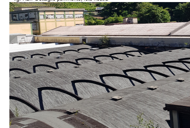
fig. 7.2.8 Esterno, vista sulla copertura, foto nostra
