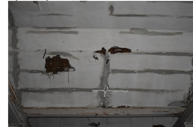
fig. 7.4.5 Dettaglio solaio, foto nostra
