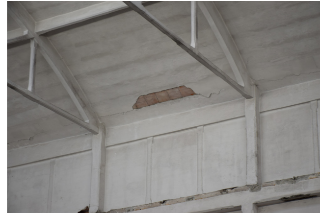
fig. 7.16.10 Dettaglio copertura, foto nostra
