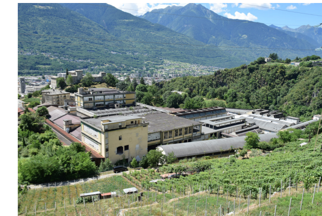
fig. 6.16 Vista da via Carlo Besta, foto nostra
