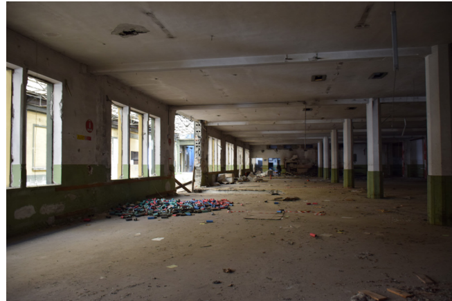
fig. 7.9.4 Interno, piano terra, foto nostra
