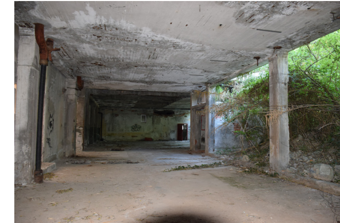
fig. 7.10.1 Esterno, passaggio coperto, foto nostra
