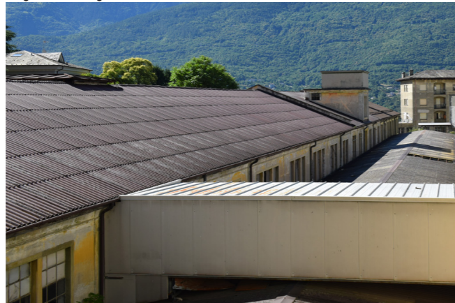
fig. 7.9.9 Esterno, vista sulla copertura, foto nostra
