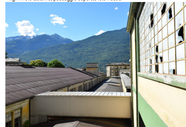
fig. 7.13.6 Esterno, vista sulla copertura, foto nostra
