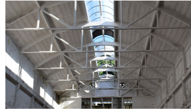
fig. 10.12.2 Copertura, Edificio 16, foto nostra
