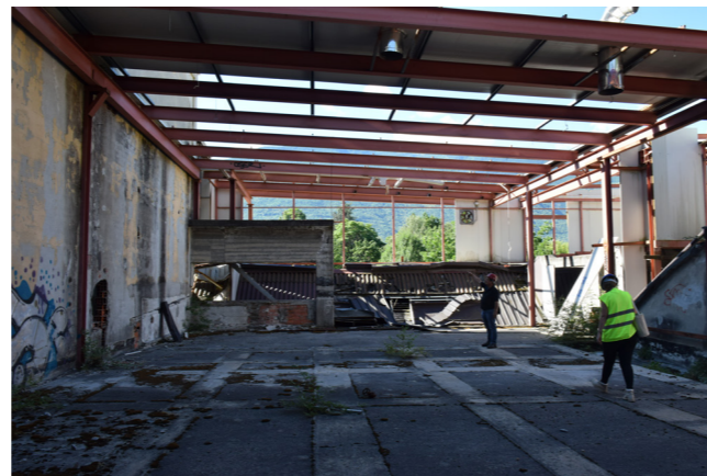
fig. 7.11.1 Esterno, copertura, foto nostra
