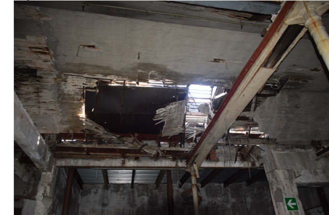
fig. 7.4.6 Dettaglio solaio, foto nostra
