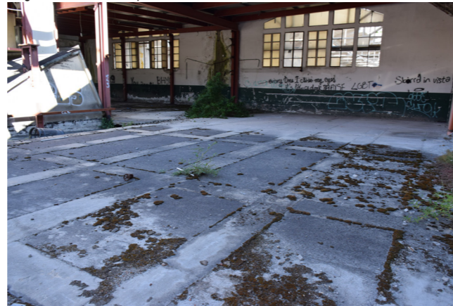
fig.7.11.3 Esterno, copertura, foto nostra
