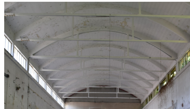
fig. 10.14.2 Copertura, sezione est Edificio 19, foto nostra
