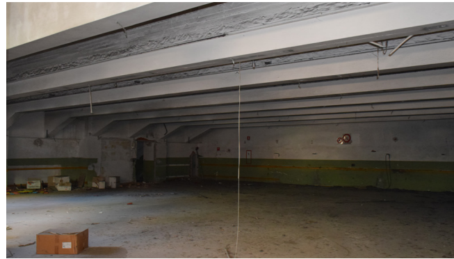
fig. 10.10.1 Piano terra Edificio 14, foto nostra
