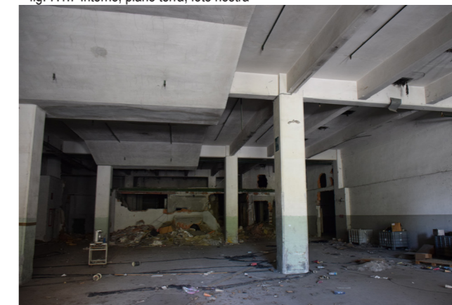
fig. 7.1.8 Interno, piano terra, foto nostra
