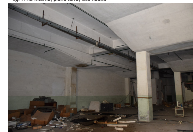
fig. 7.1.9 Interno, piano terra, foto nostra
