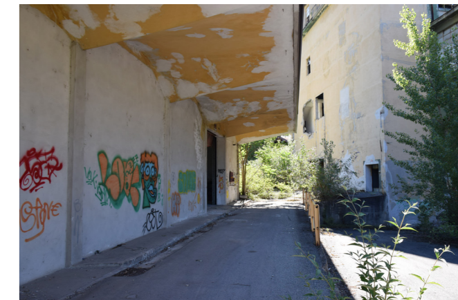
fig. 7.19.1 Esterno, vista dal cortine, foto nostra
