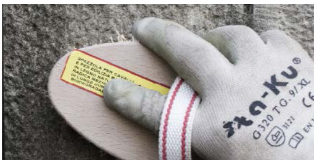
fig. 11.7.1 Sequenza delle principali fasi di lavorazione per la rimozione della patina biologica, in particolare si può osservare una prima pulitura della superficie ed eliminazione della patina, la successiva applicazione del biocida utilizzando un pennello e la conseguente spazzolatura della superficie trattata
