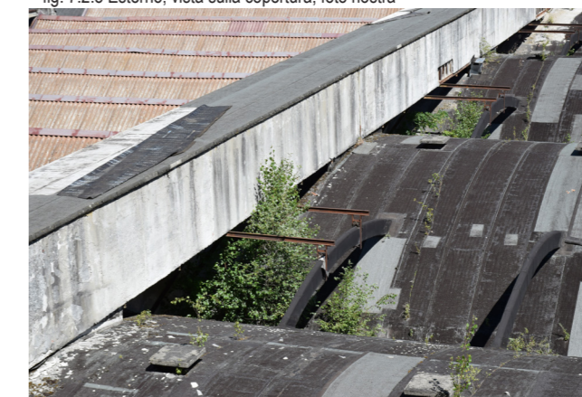
fig. 7.2.9 Esterno, vista sulla copertura, foto nostra
