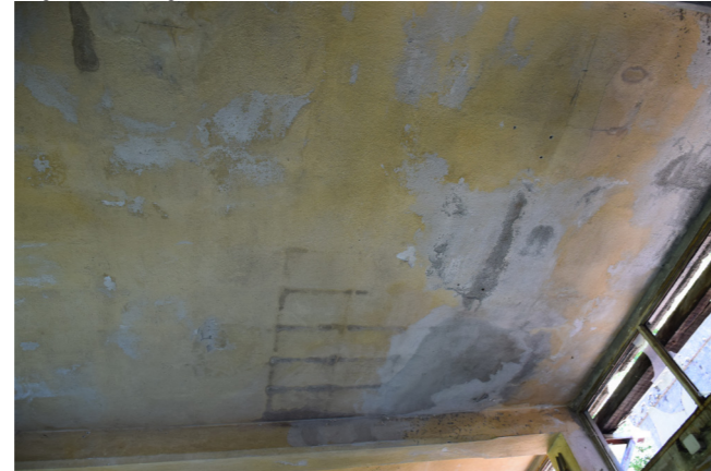
fig. 7.20.8 Dettaglio solaio, foto nostra
