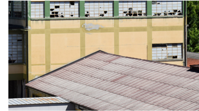
fig. 10.13.2 Copertura, Edificio 8, foto nostra
