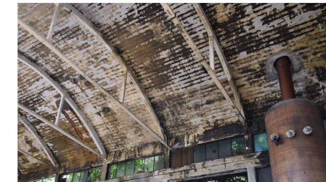
fig. 10.15.2 Copertura, sezione ovest Edificio 19, foto nostra
