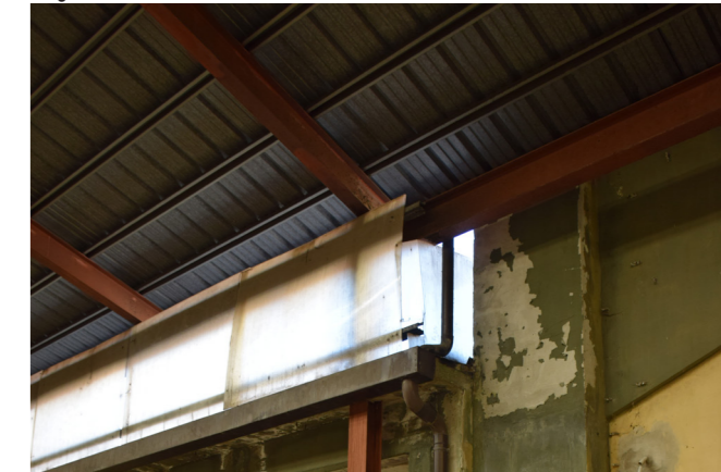
fig. 7.21.3 Dettaglio struttura metallica, foto nostra
