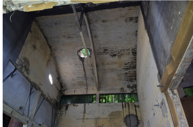
fig. 7.19.5 Dettaglio copertura, foto nostra
