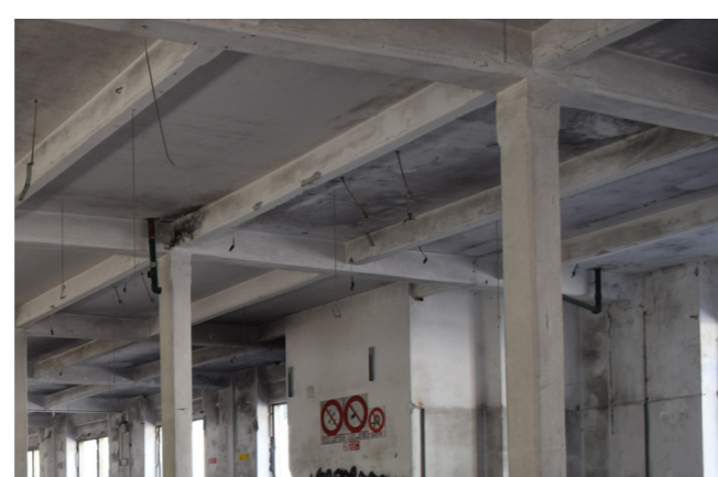
fig. 7.8.7 Dettaglio copertura, foto nostra
