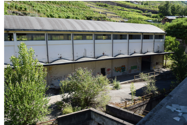
fig. 7.19.12 Esterno, vista dall'Edificio 13, foto nostra
