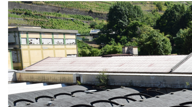
fig. 10.13.3 Copertura, Edificio 8, foto nostra
