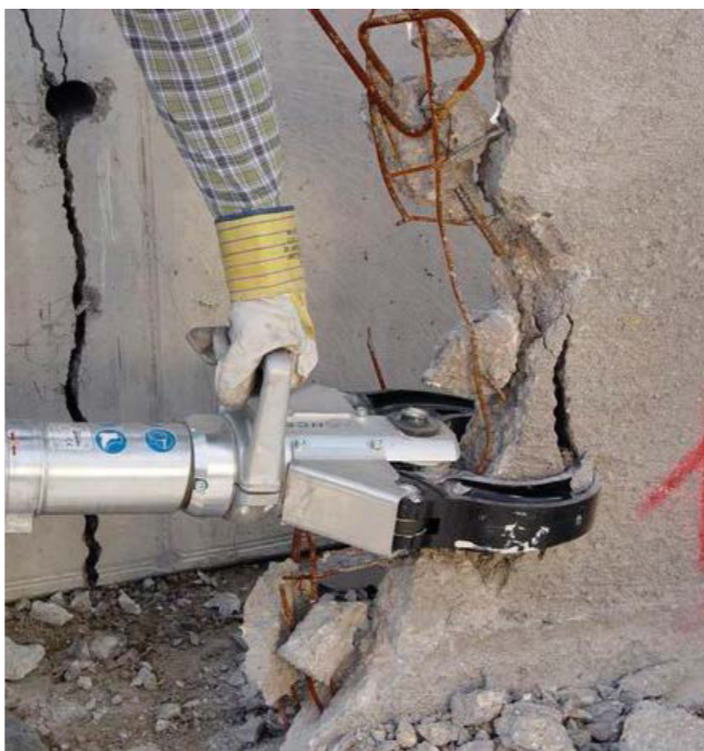
fig. 11.3.2 Demolizione di muratura in cemento armato con cesoia idraulica manuale
