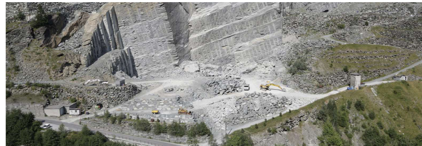
fig. 5.5 Cava di serpentino a spacco presso Sasso Corvi a Chiesa in Valmalenco (SO), foto presa da www.serpentino.com
