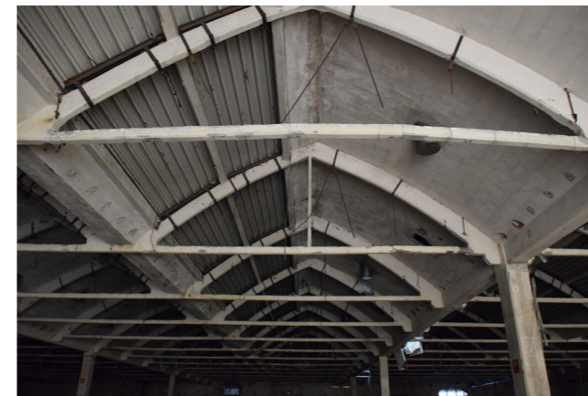
fig. 7.2.4 Dettaglio copertura, foto nostra
