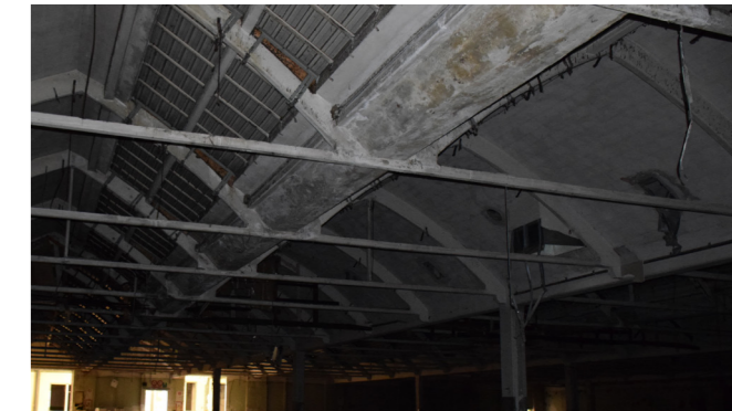
fig. 10.11.3 Copertura, Edificio 2, foto nostra
