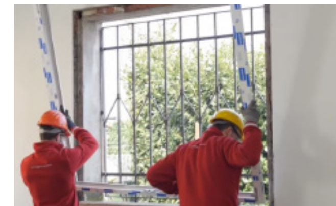
fig. 11.10.1 Alcune fasi chiave per la sostituzione degli infissi
