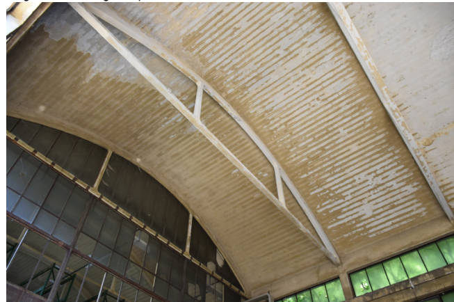
fig. 7.19.6 Dettaglio copertura, foto nostra
