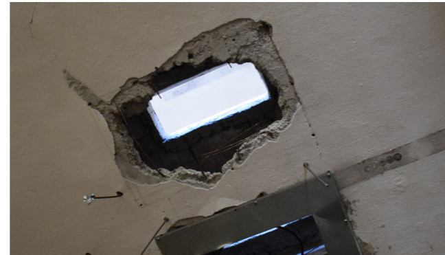
fig. 10.18.3 Solaio, Edificio 9, foto nostra
