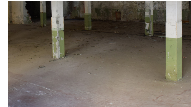
fig. 10.21.3 Pavimento Edificio 8, foto nostra
