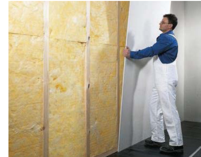
fig. 11.2.1 Posa dello strato di finitura della coibentazione interna
