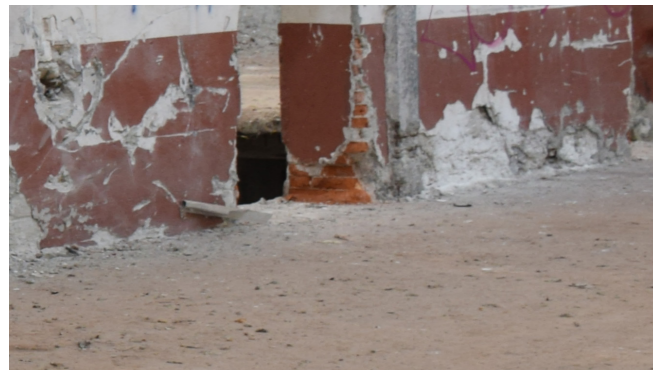
fig. 10.1.1 Parete centrale, Edificio 16, foto nostra
