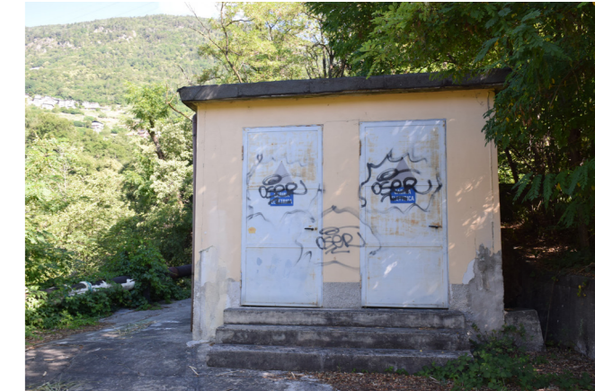
fig. 7.20.1 Cabina elettrica, foto nostra
