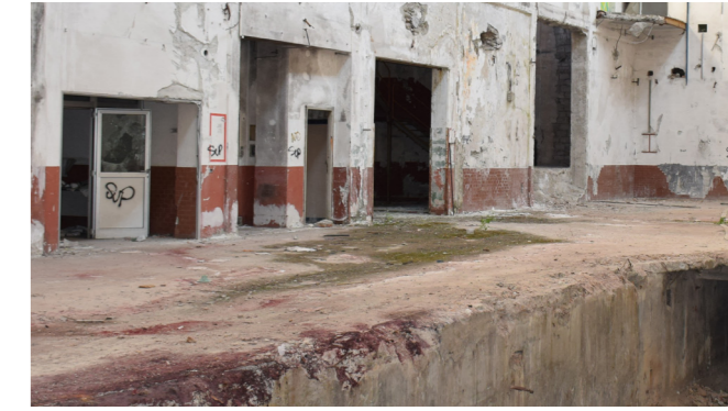
fig. 10.21.2 Pavimento Edificio 16, foto nostra
