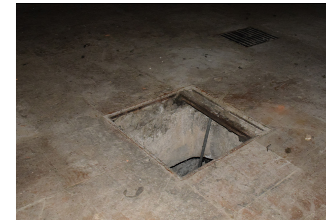
fig. 7.2.7 Dettaglio pavimento, foto nostra
