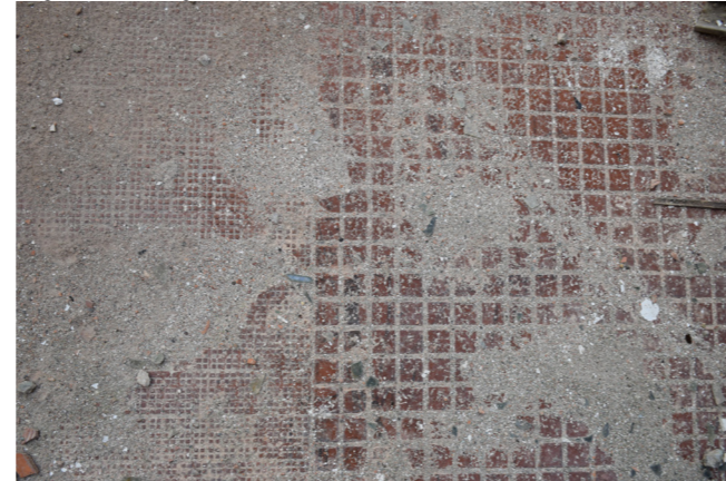
fig. 7.16.11 Dettaglio pavimento, foto nostra
