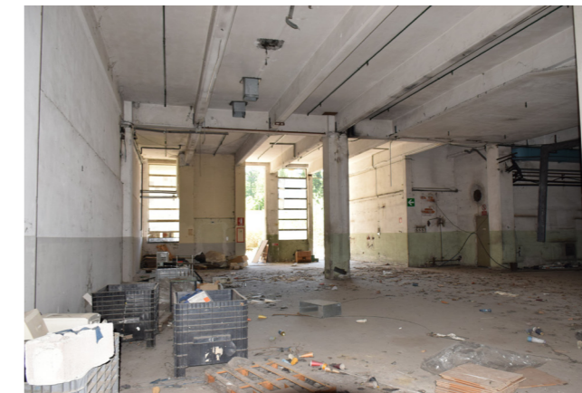
fig. 7.1.7 Interno, piano terra, foto nostra
