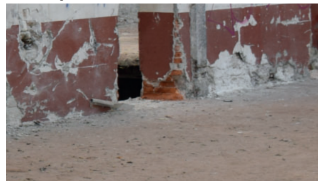
fig. 10.1.1 Parete centrale, Edificio 16, foto nostra
