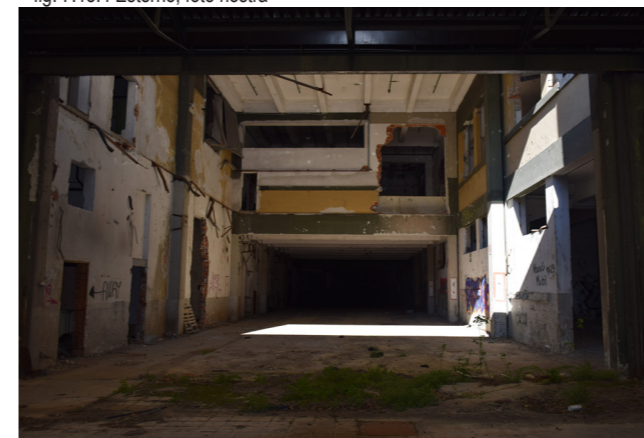
fig. 7.13.5 Esterno, passaggio coperto, foto nostra
