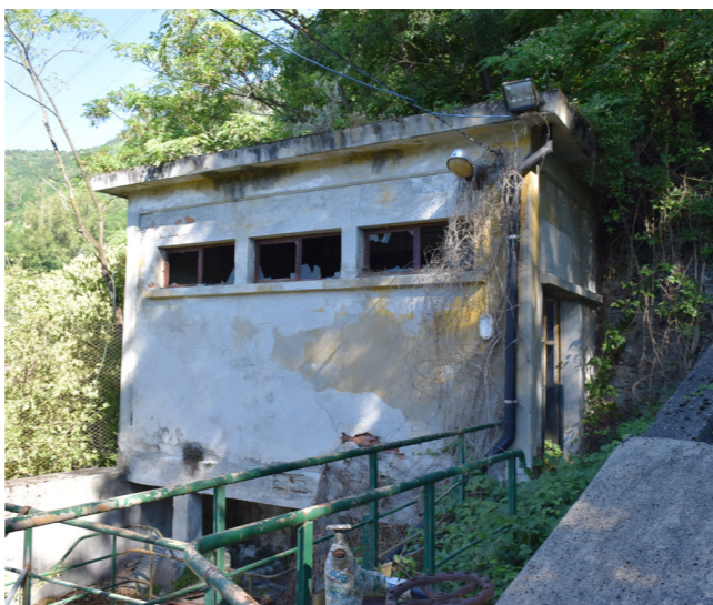
fig. 5.3 Centrale idroelettrica, foto nostra
