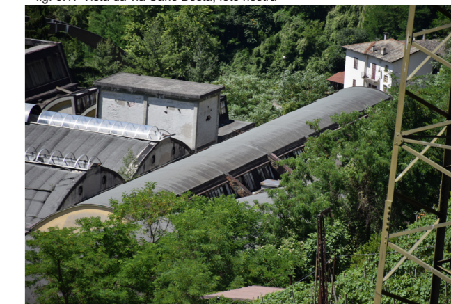
fig. 6.18 Vista da via Carlo Besta, foto nostra
