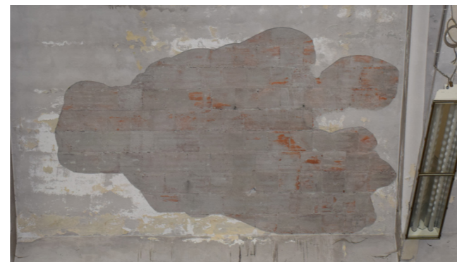
fig. 10.14.3 Copertura, sezione est Edificio 19, foto nostra
