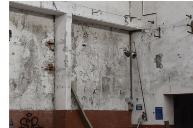
fig. 9.2.1 Deposito superficiale, foto nostra
