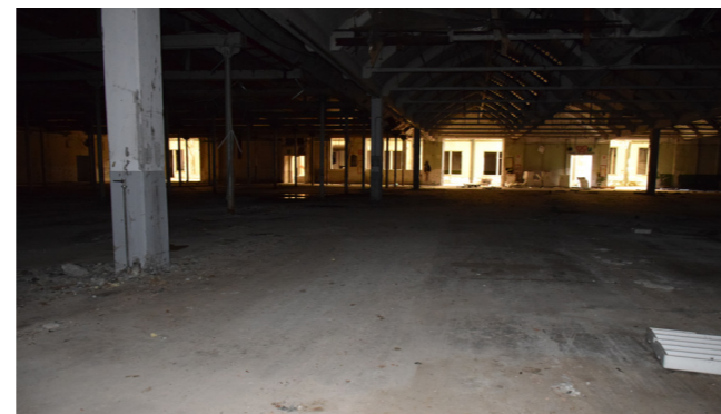
fig. 10.16.3 Pavimento, Edificio 2, foto nostra
