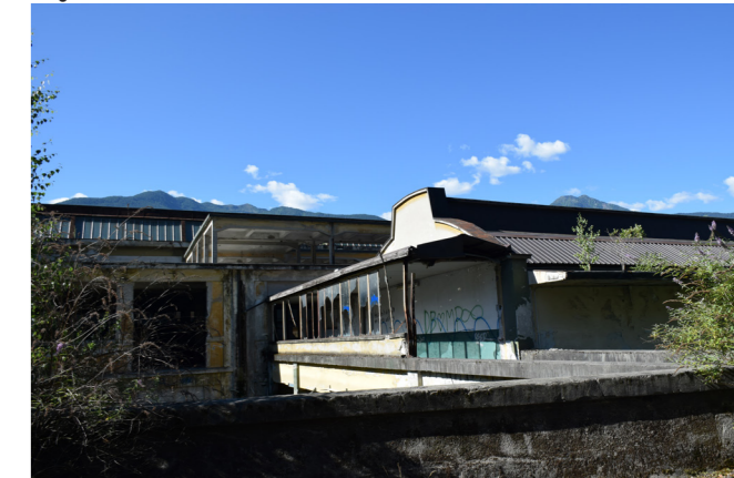
fig. 7.17.3 Dettaglio passaggio sopraelevato, foto nostra
