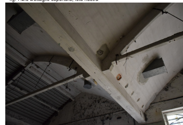
fig. 7.2.6 Dettaglio copertura, foto nostra
