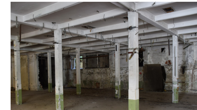
fig. 10.17.2 Solaio Edificio 8, foto nostra
