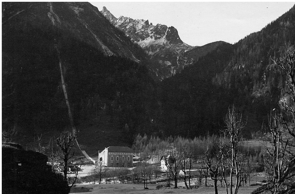
Centrale idroelettrica di Valdo. Formazza (Verbano-Cusio-Ossola), frazione Valdo 1920-1923 Fondazione Piero Portaluppi, Milano
