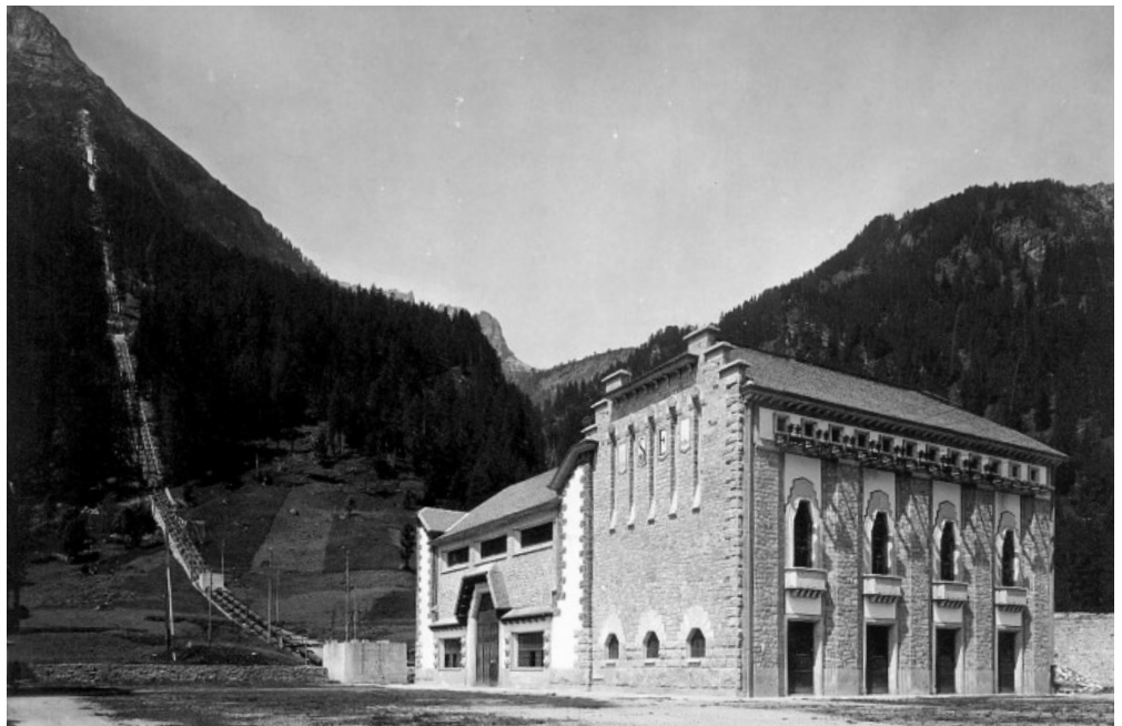
Centrale idroelettrica di Valdo Formazza (Verbano-Cusio-Ossola), frazione Valdo 1920-1923 Fondazione Piero Portaluppi, Milano
