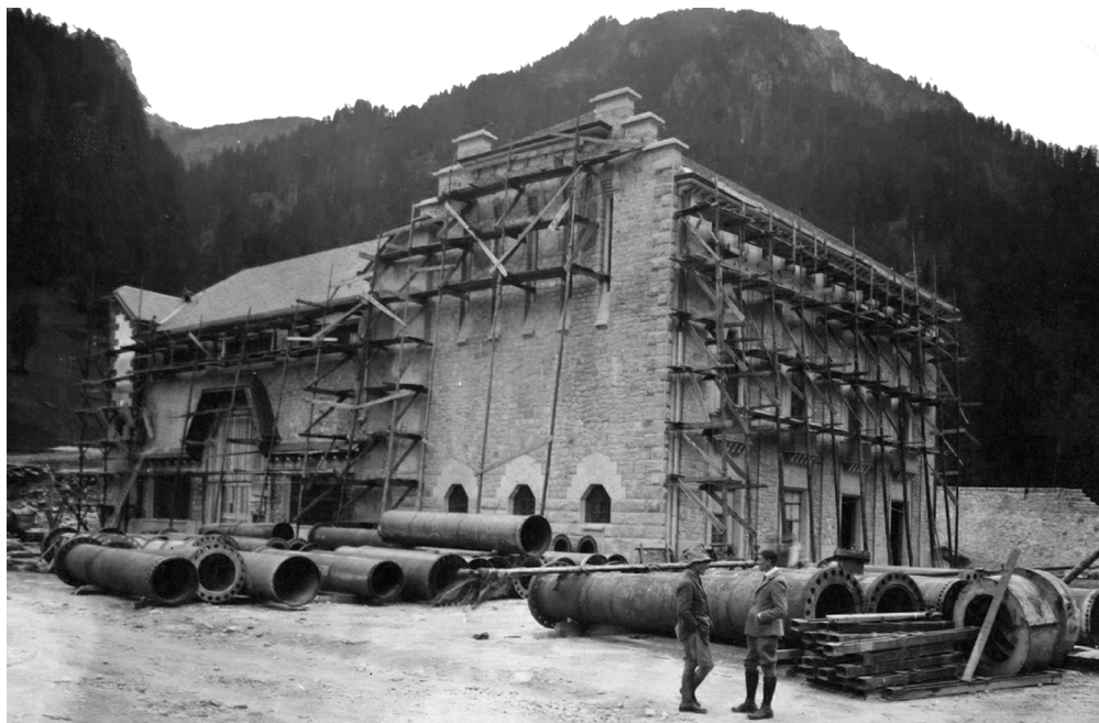
Centrale idroelettrica di Valdo. Cantiere. Formazza (Verbano-Cusio-Ossola), frazione Valdo 1920-1923 Fondazione Piero Portaluppi, Milano
