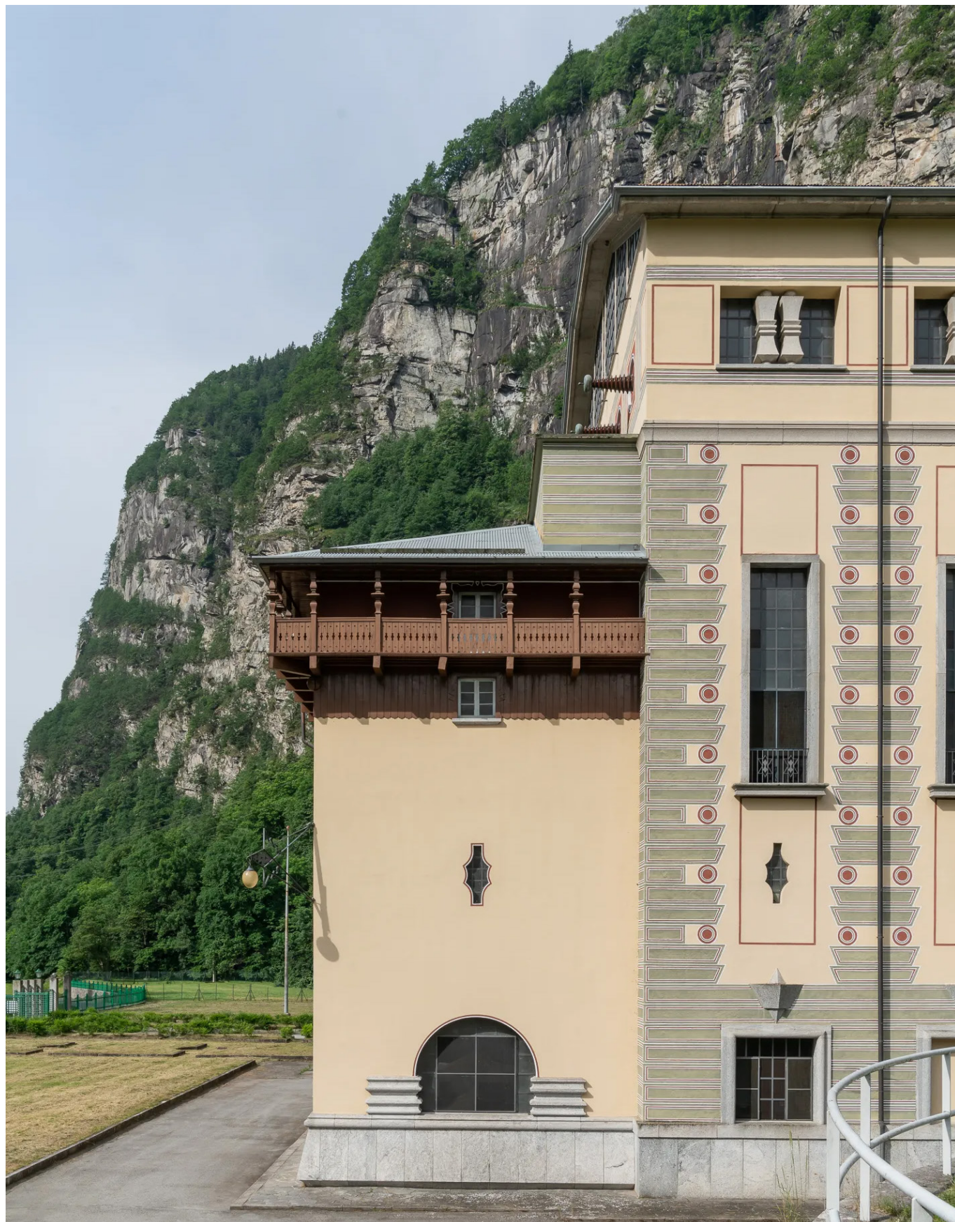
Centrale di Cadarese
