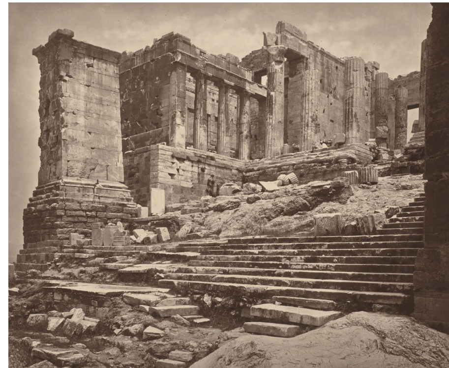
Fotografia dell'ingresso dei Propilei, William James Stillman, 1882
