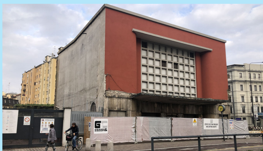
Figura 4.A6: Cantiere in corso d'opera per la riqualificazione del cinema Marstoso, 2020.
