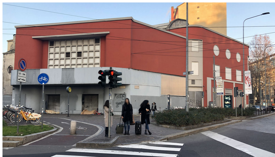
Figura 6.03: Vista dell'ex cinema Maestoso in corso Lodi.
