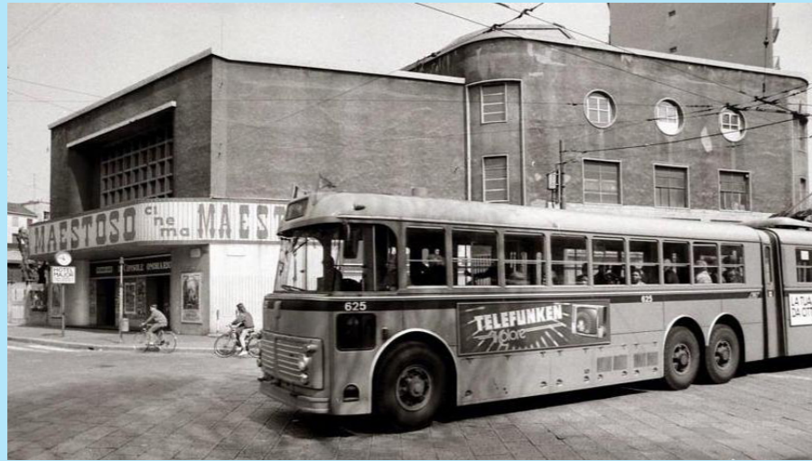
Figura 4.A3: Edificio cinema Maestoso, 1983.
