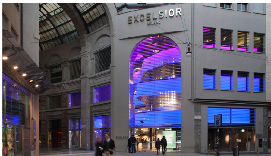
Figura 3.02: Vista dell'ingresso e della facciata da via Passarella dell'Excelsior Milano a cura di Jean Nouvel.
