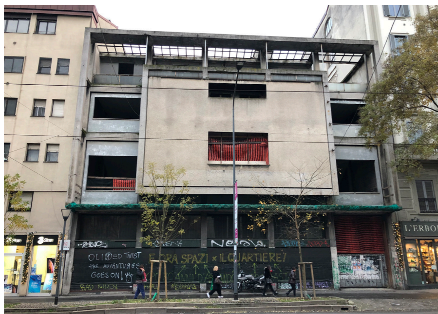
Figura 6.09: Vista esterna della condizione in cui versa oggi l'ex cinema XXII Marzo.
