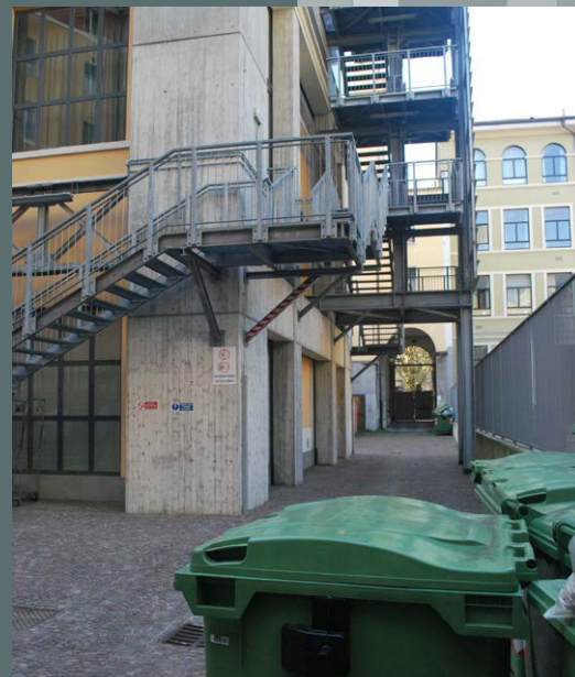
1. scala antincendio auditorium
