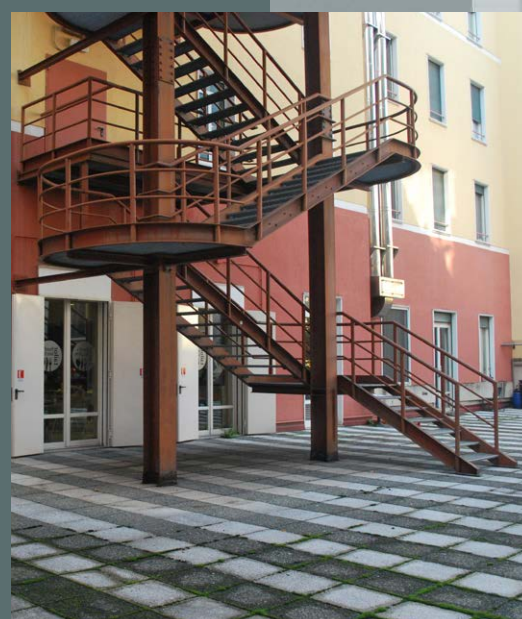
3. scala antincendio ala ovest
