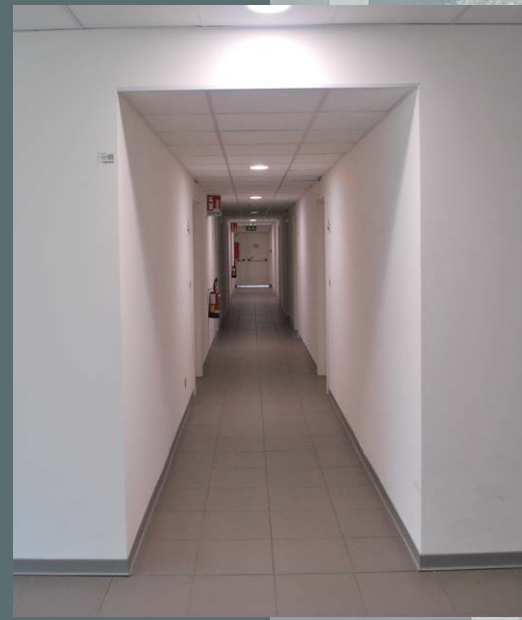
2. corridoio ala centrale
