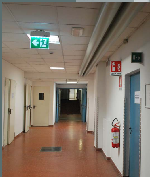
3. corridoio su vani tecnici
