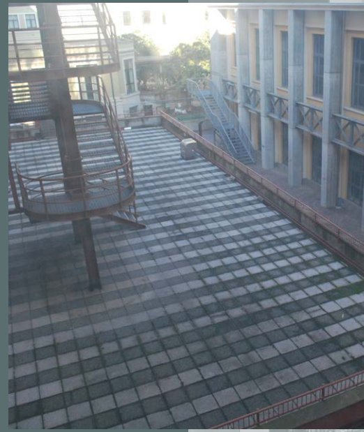
3. vista dalla finestra in testata
