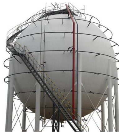
Figura 19: Serbatoio sferico di 6000 m 3 contenente GPL.
