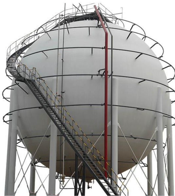
Figura 3.25_36: Serbatoio sferico di 6000 m3 contenente GPL.
