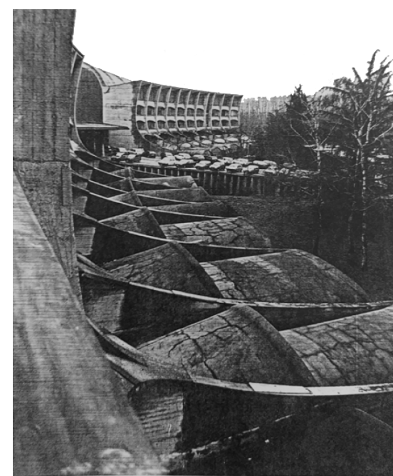
Veduta della copertura degradata delle volte dei laboratori dalle aule dei piani superiori
