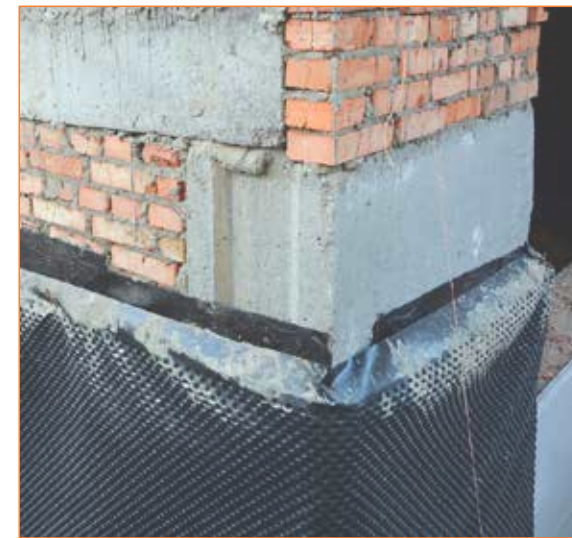
Dettaglio del risvolto sul lato
