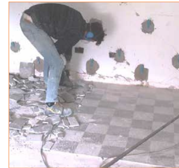
Operazione di demolizione
