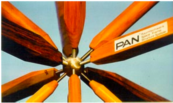
Pan-knot(27,Bauen mit Bambus)
