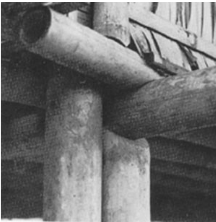
Doublejamb as support (27,Bauen mit Bambus)
