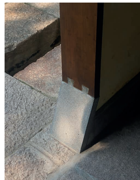
figura 44 Incastro a coda di rondine, Jiading Farm Archivio personale, 2025
