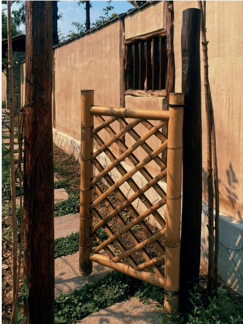
figura 45 Dettaglio costruttivo, Jiading Farm Archivio personale, 2025
