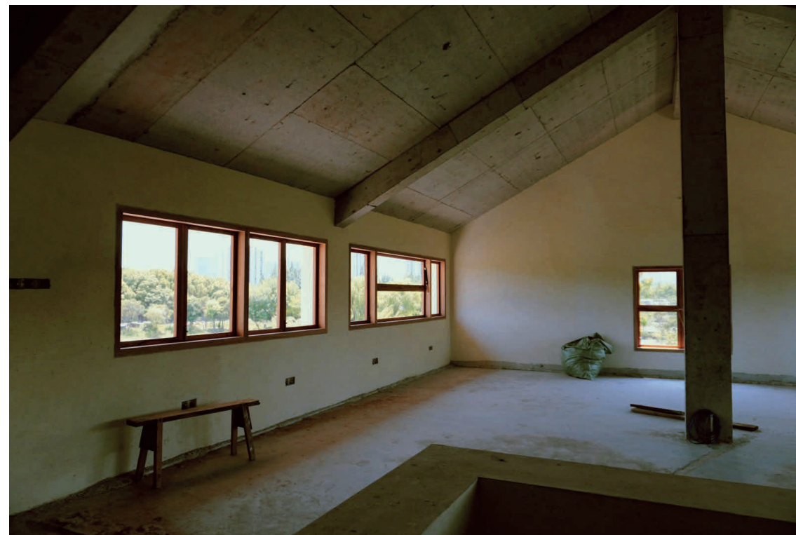
figura 31 Sala da pranzo comune in costruzione, Jiading Farm Archivio personale, 2025
