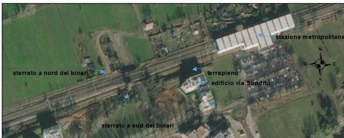
Figura 4.1: Tratto di metropolitana in prossimità della stazione di Cascina Antonietta, oggetto delle misure.
