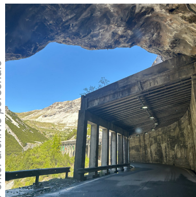
Paravalange in corrispondenza della V galleria. 13 giugno 2026. Fonte: archivio personale
