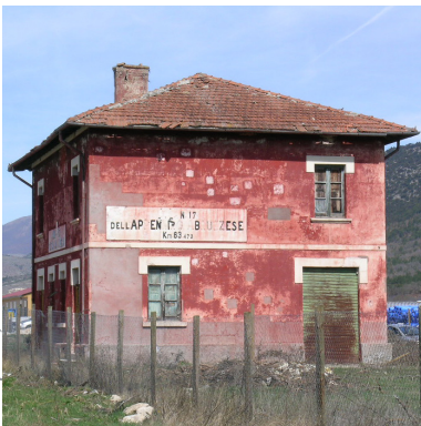
Casa Cantoniera di Caporciano, L'Aquila, fonte: Anas
