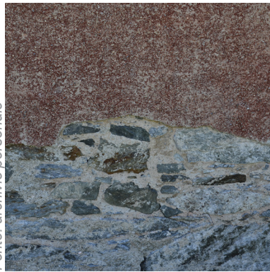
Lacuna e alterazione cromatica delle pietre, 13 giugno 2026. Fonte: archivio personale
