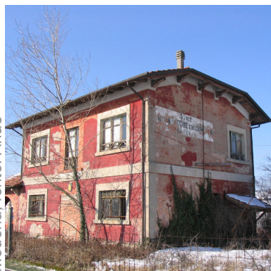
Casa Cantoniera di Maranello, Modena, fonte: Anas
