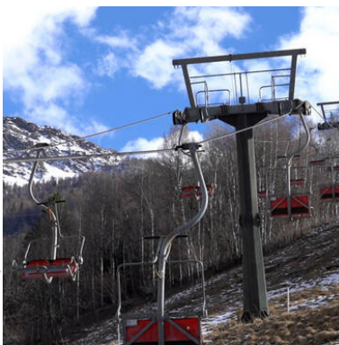
Impianti di risalita abbandonati a Montecampione. 2022. Fonte: quibrescia.it
