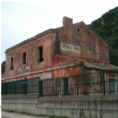
Casa Cantoniera di Burcei, Cagliari, fonte: Anas
