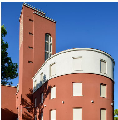
Casa del Balilla, Forlì. Fonte scopriforli.it
