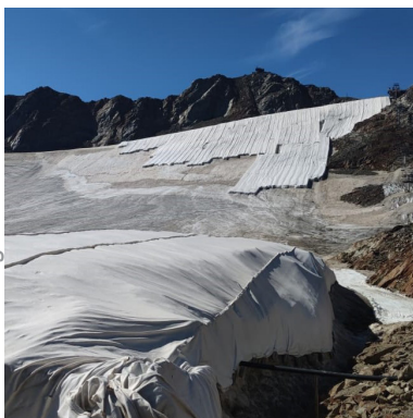
Teli geotessili in Val Senales. 2022. Fonte: altoadigeinnovazione.it
