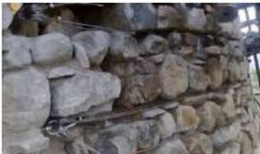
1. Consolidamento della muratura faccia a vista della Torre nord del Castello di Compiano (Parma): particolare dei dispositivi di ancoraggio dei trefoli in acciaio [Fonte: www.teknoring.com/]
