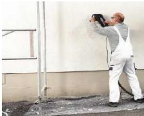
1. Rimozione dell'intonaco tramite fresatrice [Fonte: festool.it]
