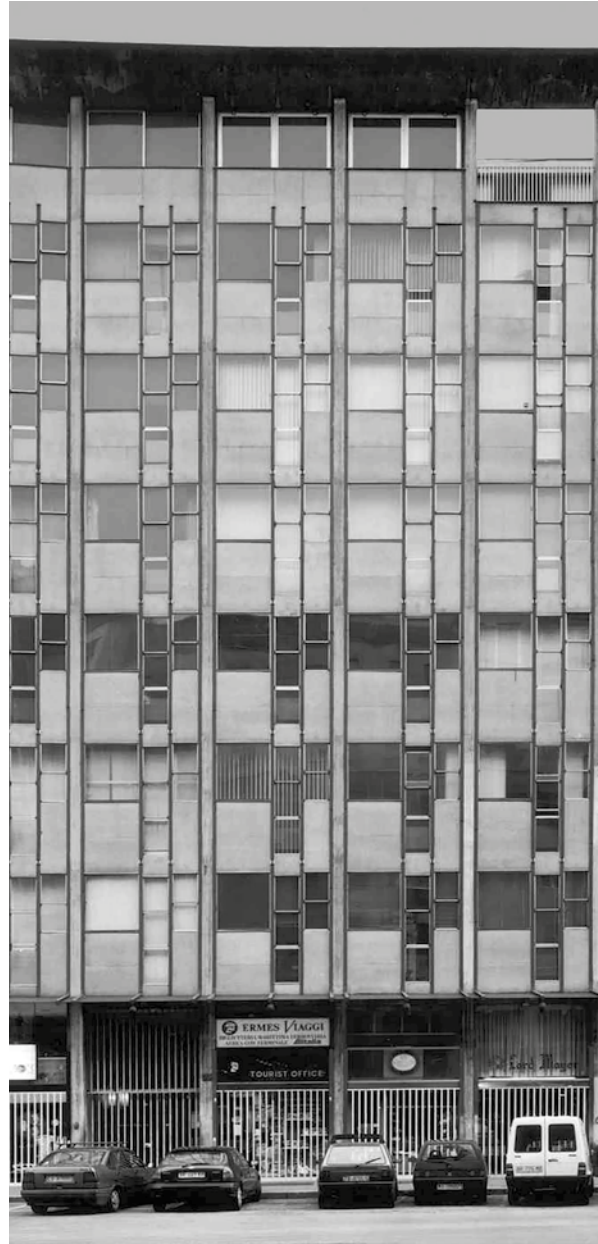
Office Building in Corso Europa Vico Magistretti, Milan
