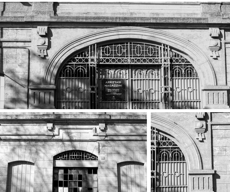
54) dettagli della facciata di alcuni Magazzini Fonte immagini: progetto fotografico personale
