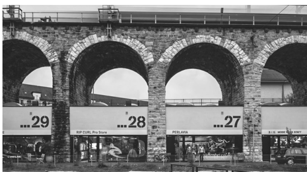
68) Viadukt all'altezza degli ex-magazzini 27-28 e 29 fonte: EM2N.CH/Projects, Archdaily
