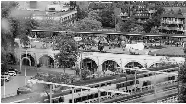
70) Viadotto e Stazione Hofplein, Rotterdam fonte: teknoring.it
