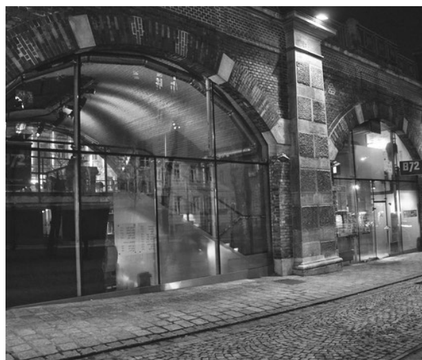
72) Il viadotto Stadtbahn di Vienna dopo l'intervento di riqualificazione fonte: https://www.schnappen.at/oesterreich/index.php/schwerpunkt-wien/wien/1233-wien-b72
