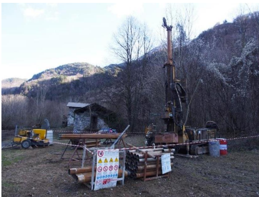
Figura 5.2. Perforazione eseguita tramite sonda a rotazione con l'utilizzo di doppio carotiere. Da "Analisi di fattibilità sull'utilizzo di metodi geofisici per lo studio della frana di Piuro (SO)" tesi di Anna Zinetti.
